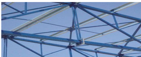
Εικόνα 10. Λεπτότοιχες τεγίδες επι μεταλλικού ζυγώματος.
