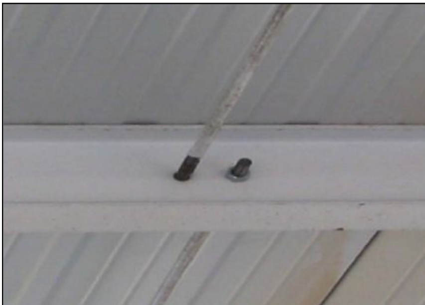
Εικόνα 15. Σύνδεση τεγίδων μέσω ελκυστήρα (ντίζας)
