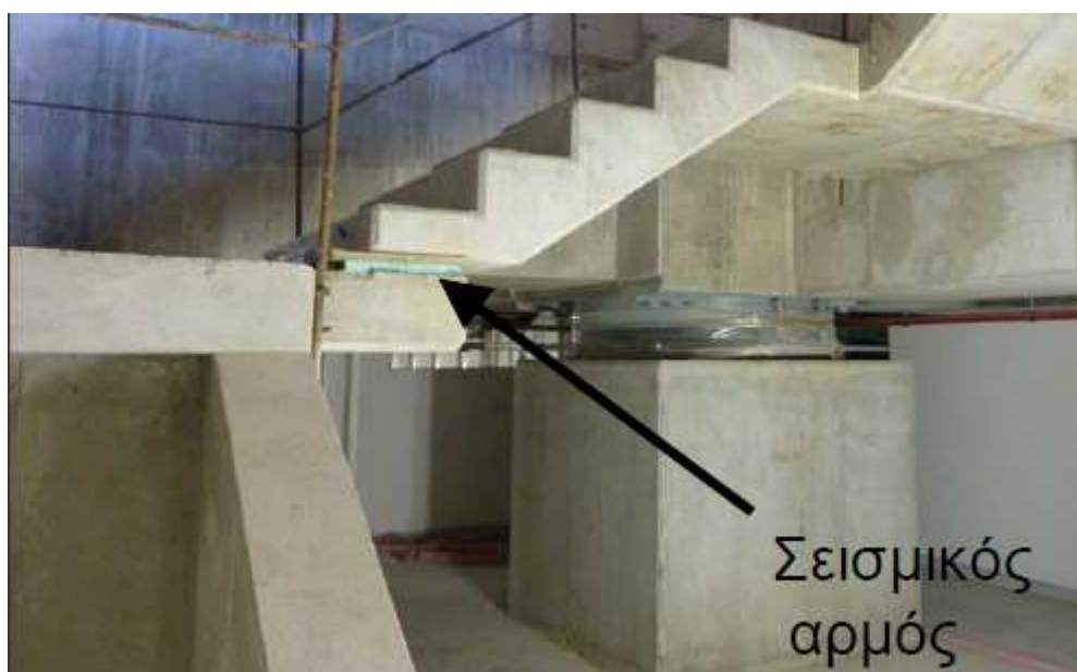
Εικόνα 25 Σεισμικός αρμός σε σκάλα [23]
