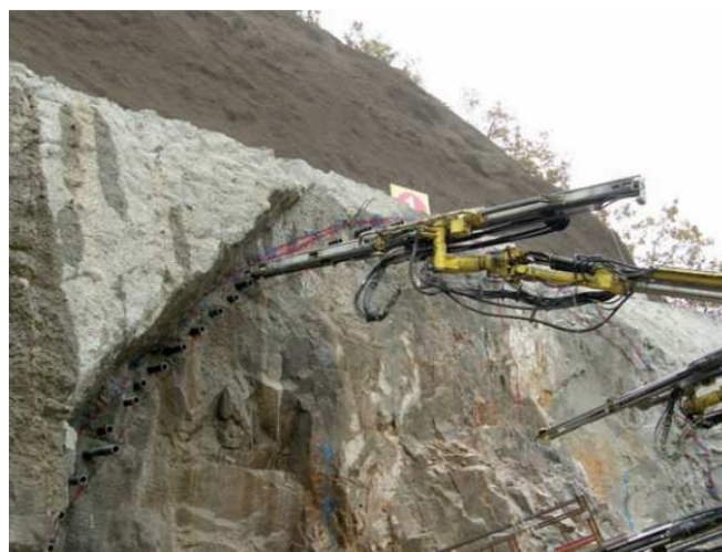
Εικόνα 33 Μέθοδος υποστήλωσης fore roling [38]
