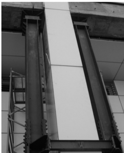
Εικόνα 27 Προσωρινή στήριξη με μεταλλικά υποστυλώματα [34]
