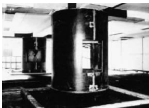
Εικόνα 28 Προσωρινή στήριξη με εγκιβωτισμό στοιχείων [3]
