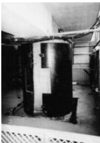
Εικόνα 28 Προσωρινή στήριξη με εγκιβωτισμό στοιχείων [3]
