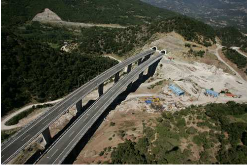
Εικόνα 7 Γέφυρα Μεγαλορέματος (ΕΓΝΑΤΙΑ ΟΔΟΣ) 2006 [27]
