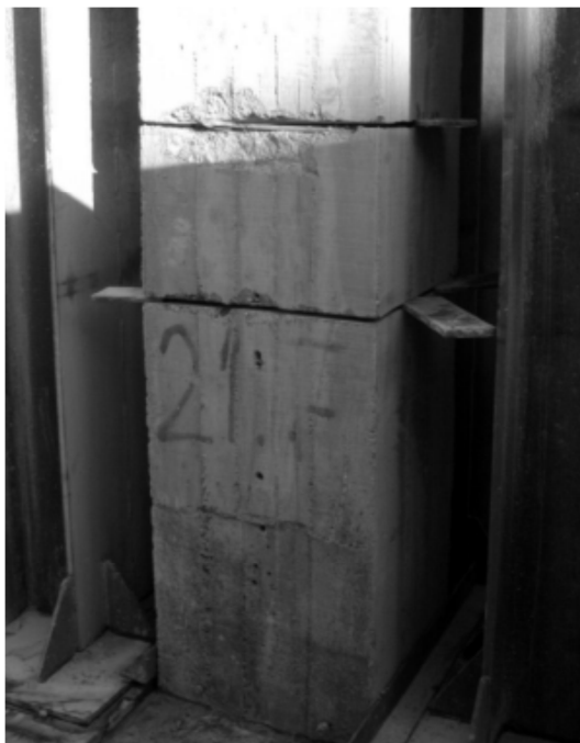
Εικόνα 34 Κοπή υφιστάμενου υποστυλώματος [34]
