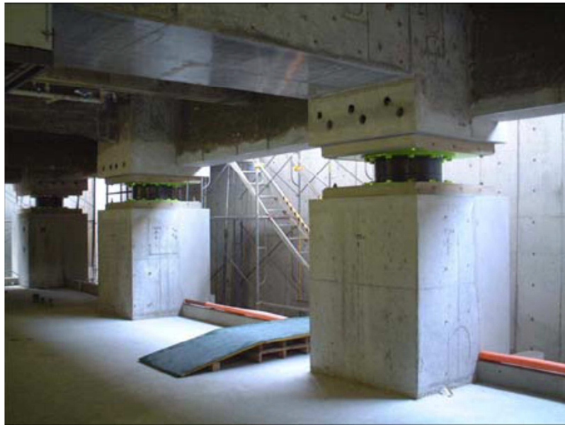
Εικόνα 37 Μανδύες οπλισμένου σκυροδέματος και εφέδρανα σε υποστυλώματα [35]
