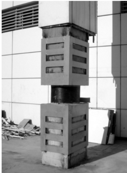
Εικόνα 38 Διαμόρφωση μεταλλικού κλωβού και εφέδρανο σε υποστυλώμα [34]
