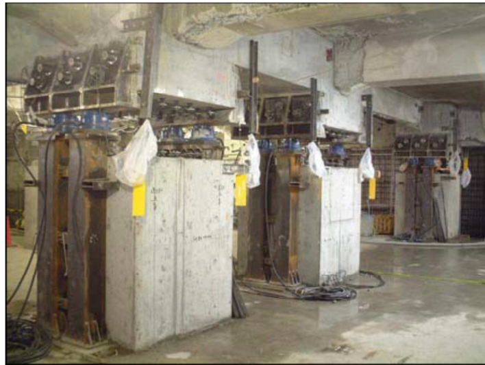
Εικόνα 30 Προσωρινή στήριξη με προεντεταμένους τένοντες και μεταλλικά στηρίγματα [35]
