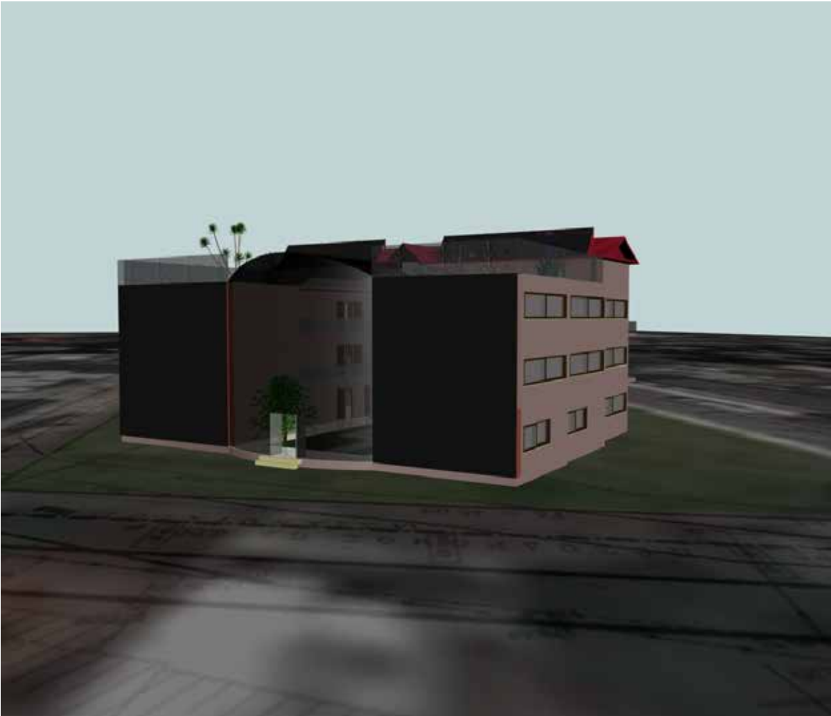
Εικόνα 3.2: Οι τοίχοι trombe τοποθετημένοι στο κτίριο.
