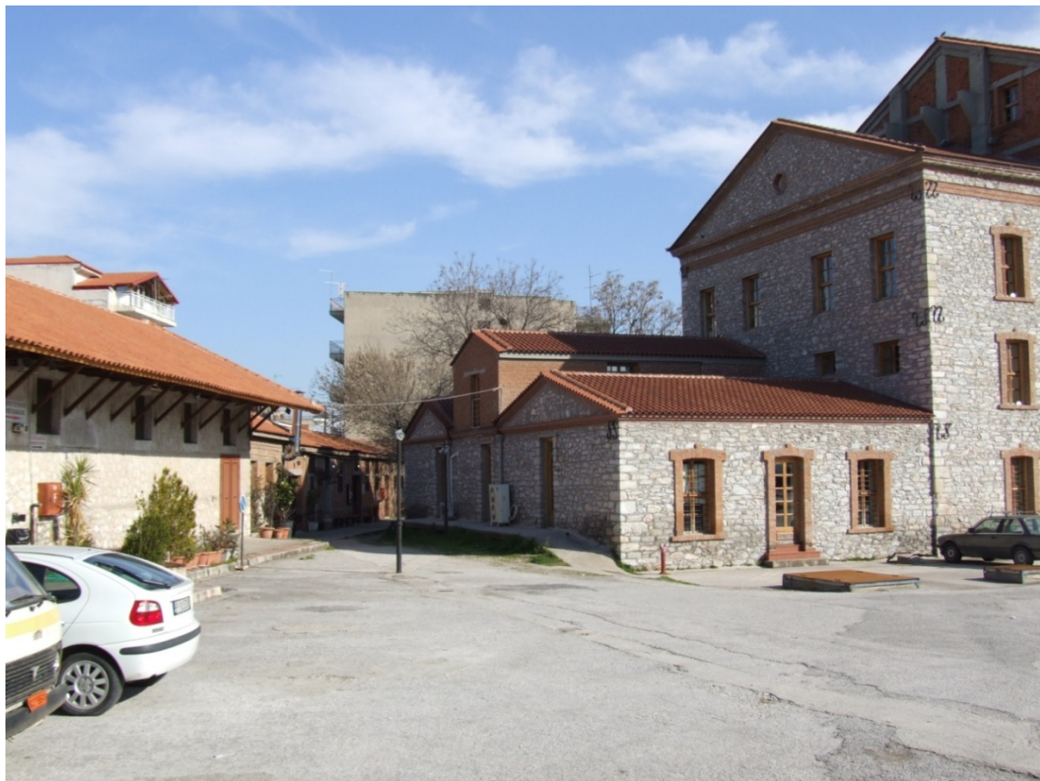
Εικόνα 13. Τα τρία κτίσματα δυτικά του κτιρίου και περιμετρικές σιταποθήκες.
