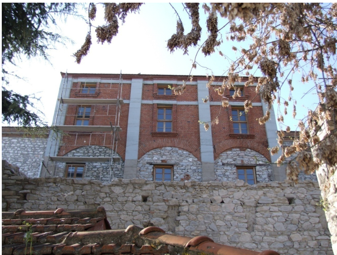
Εικόνα 16. Νότια όψη πολυώροφου κτίσματος.
