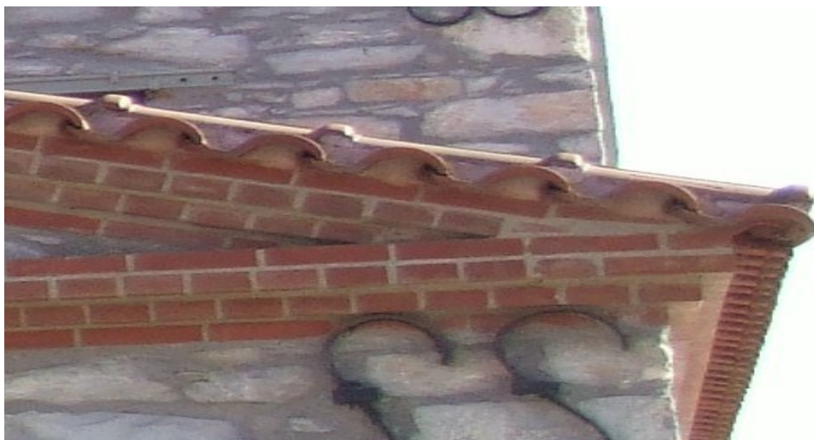
Εικόνα 9. Στέγη του κεντρικού κτιρίου του μύλου.
