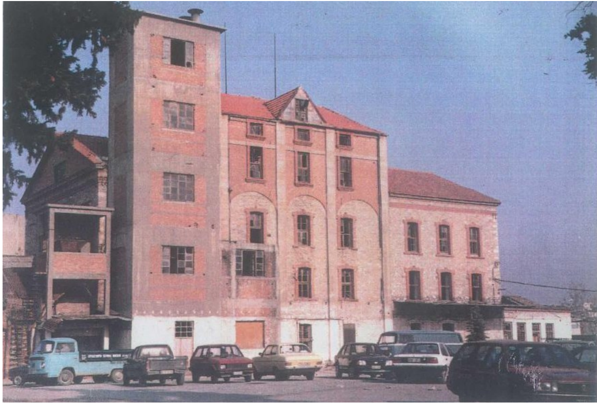
Εικόνα 10. Οι δύο πύργοι στη νότια πλευρά πριν την κατεδάφιση τους.
