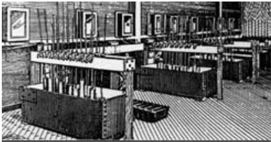
Εικ.5 Η πρώτη εγκατάσταση βιομηχανικής παραγωγής αλουμινίου το 1888 ικανότητας 20 κιλών ημερησίως, στο Πίτσμπουργκ των Η.Π.Α.
