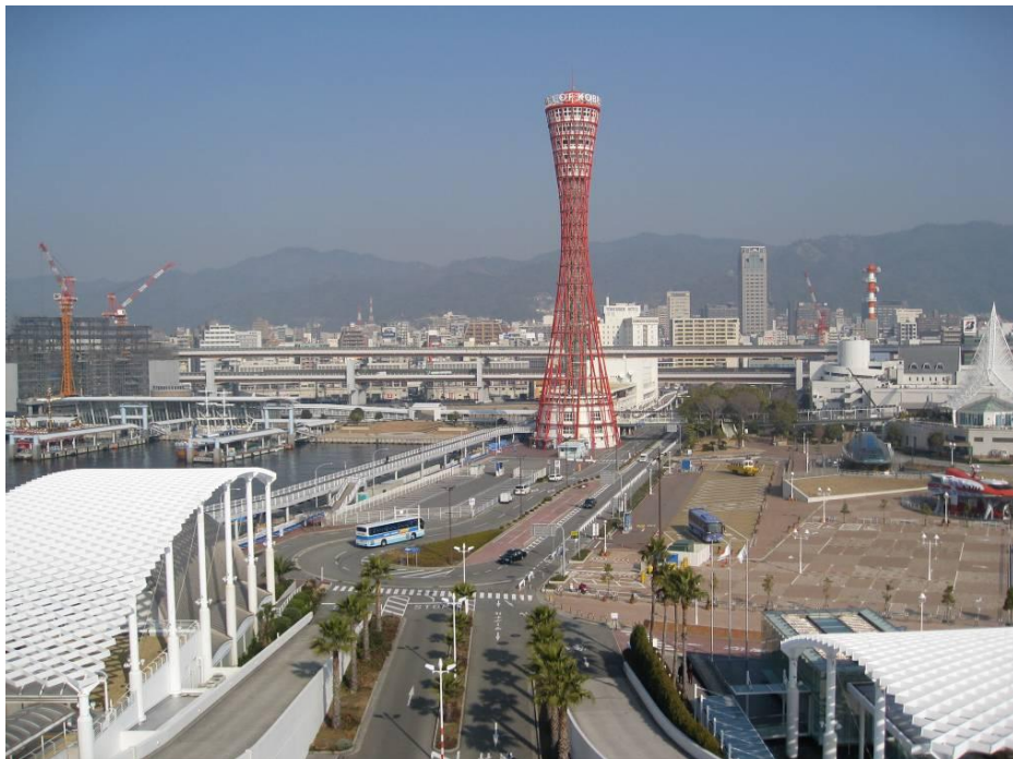
Φωτ 2. Κόμπε Ιαπωνίας, Αρχιτεκτονικές κατασκευές με αλουμίνιο. Δικτυώματα
