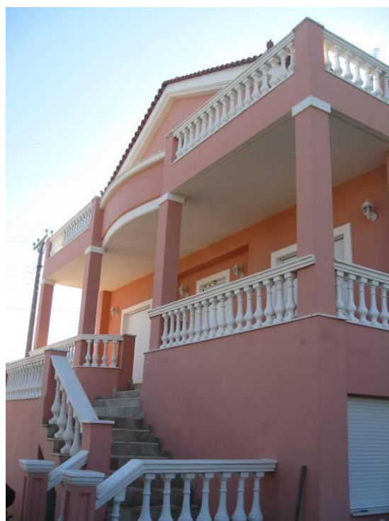
Φωτ 12. Πόρτο Ράφτη- Ελλάδα, Μελετοκατασκευή κατοικίας (Αρχιτέκτων: Καλοκύρη Καλλιόπη) Κουφώματα αλουμινίου
