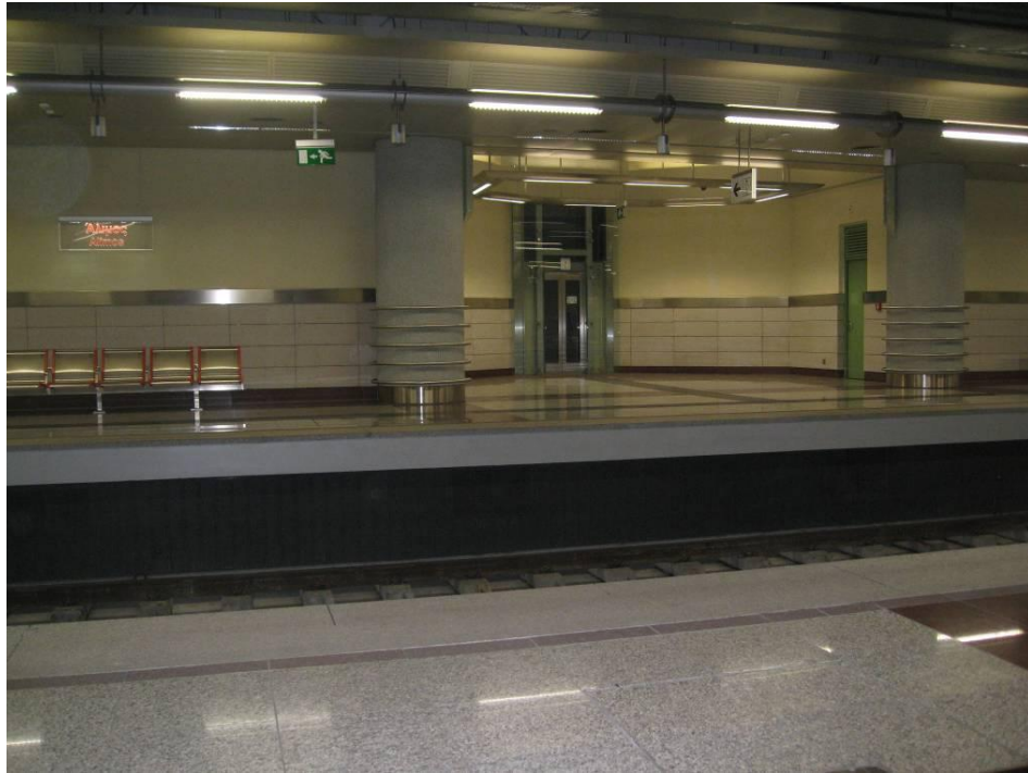
Φωτ 9. Άλιμος - Ελλάδα, Αρχιτεκτονικές κατασκευές με αλουμίνιο.Πλατφόρμα στάσης μετρό
