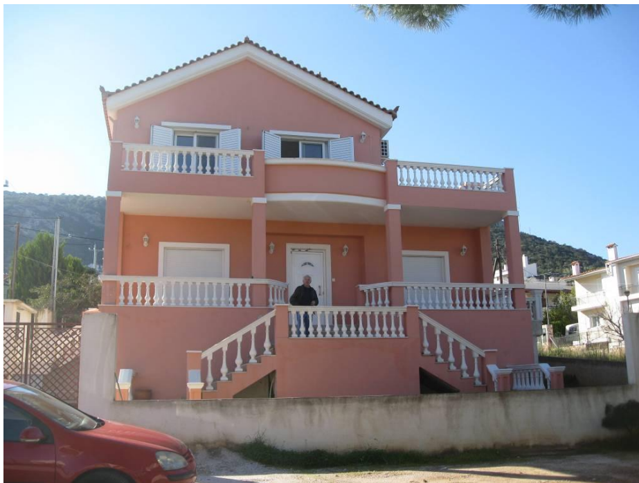
Φωτ 11. Πόρτο Ράφτη -Ελλάδα, Μελετοκατασκευή κατοικίας (Αρχιτέκτων :Καλοκύρη Καλλιόπη) Κουφώματα αλουμινίου
