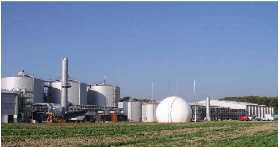
Εικόνα 22 Σταθμός θερμικής επεξεργασίας αποβλήτων στην Γερμανία
