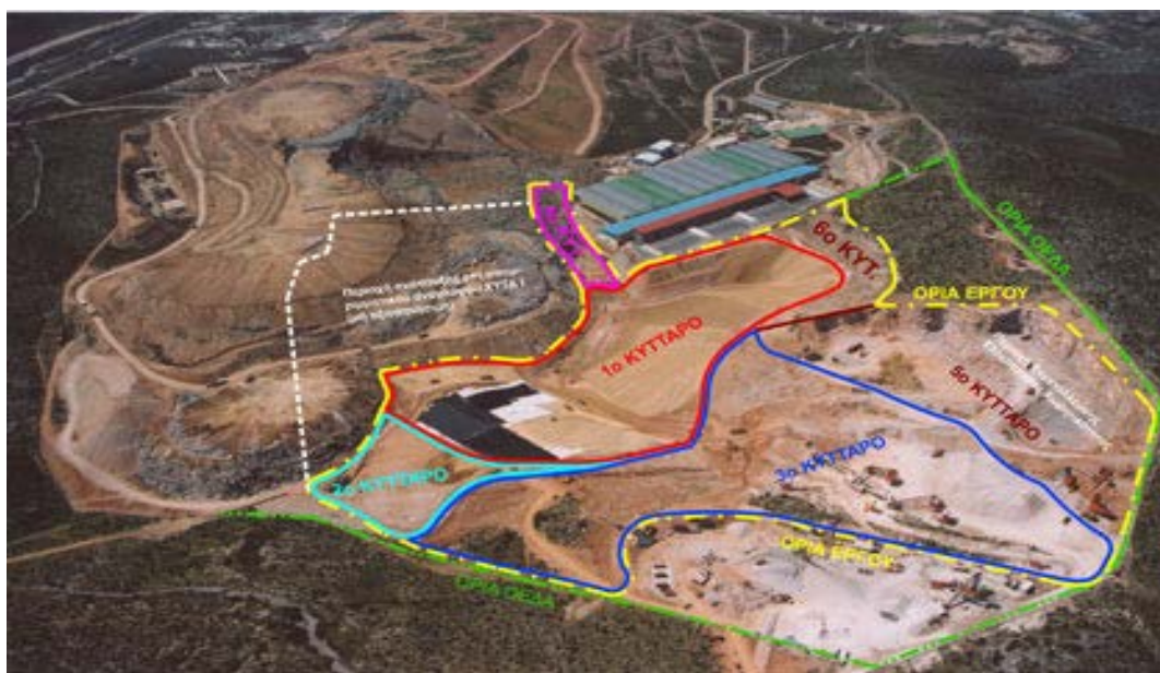
Εικόνα 33 Οι εγκαταστάσεις του ΧΥΤΑ Λιοσίων
