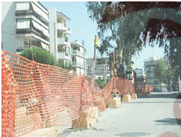
Αφαίρεση του οδοστρώματος μέχρι την στάθμη της υπόβασης και την επανατοποθέτηση της για την ενσωμάτωση της επιδομής του έργου Πηγή : http://athens.indymedia.org
