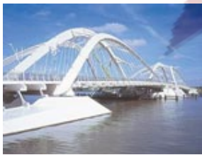
Γέφυρα από την οποία διέρχεται δίκτυο τραμ στο Άμστερνταμ
