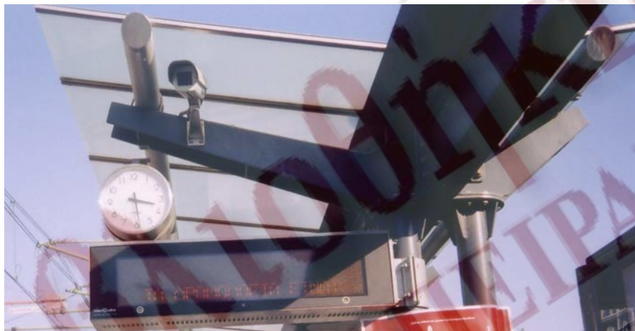
Το προστατευτικό στέγαστρο, η κάμερα ελέγχου, το ρολόι και η ειδική οθόνη που ενημερώνει για το χρόνο άφιξης του επόμενου συρμού
