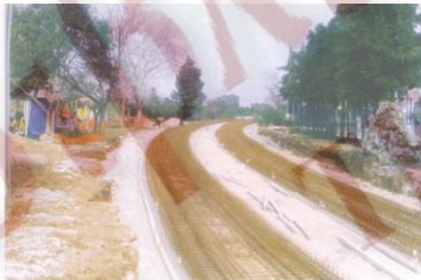
Διαδικασίες σκυροδέτησης των ραγών. Πηγή : www.tramsa.gr
