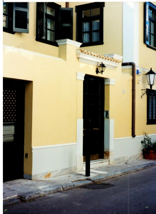
Εικόνα 53 : Νεοκλασικό κτίριο της Αθήνας
