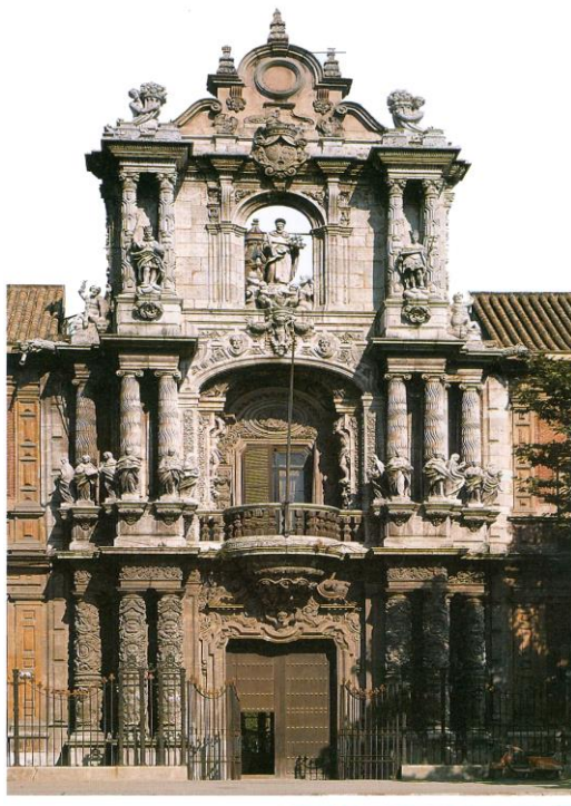
Εικόνα 49 : Μέγαρο του σαν τέλμο Πηγή: https://Palace_of_San_Telmo
