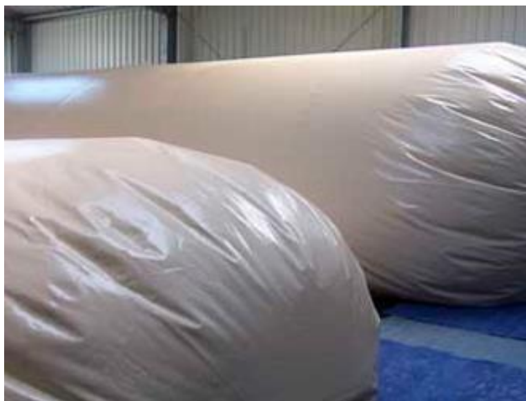
Εικόνα 4.10. Σάκος βιοαερίου σε εξωτερικό οίκημα.
