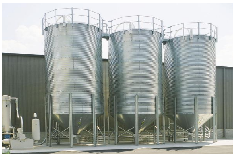
Εικόνα 4.1. Δεξαμενές αποθήκευσης υγρών αποβλήτων.
