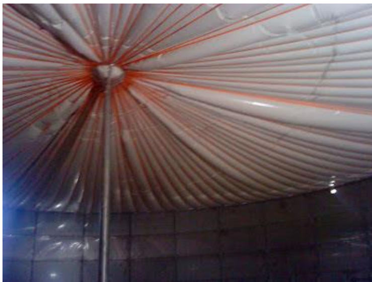
Εικόνα 4.3. Εσωτερική εικόνα του θόλου συλλογής βιοαερίου
