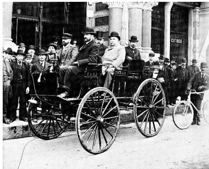
Εικόνα 2.4. Ηλεκτρικό όχημα αυτονομίας 13h και ταχύτητας 22,53 km/h (William Morrison, 1890).
