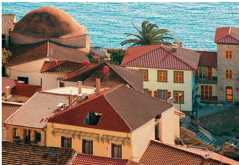
Εικ.29: Υφιστάμενη κατάσταση στέγης, Φετιχιέ τζαμί
