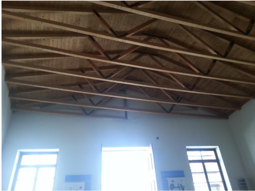
Εικ.15: Ξύλινα ζευκτά δίρριχτης στέγης, Φετιχιέ τζαμί
