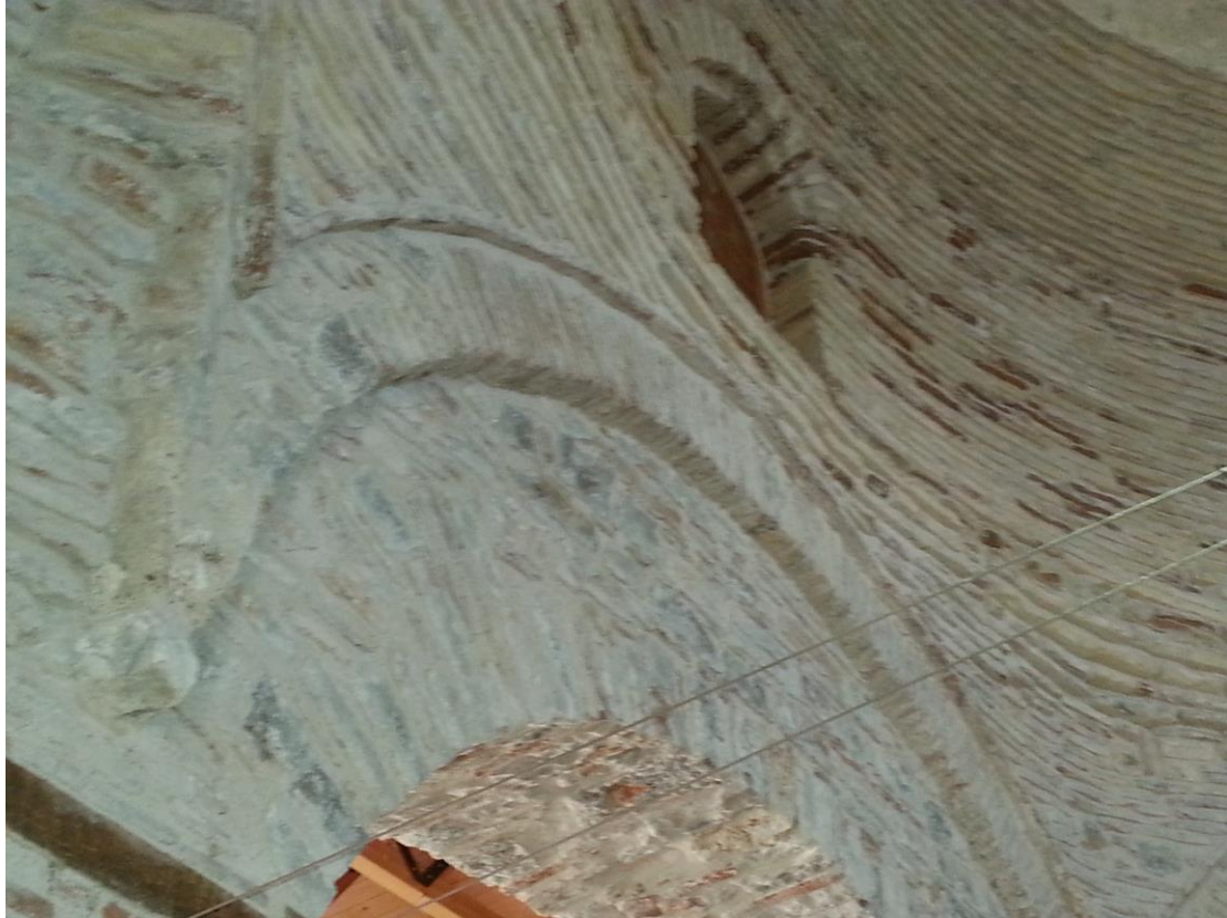
Εικ. 3: Οξυκόρυφο παράθυρο με παραβολοειδή τόξα Φετιχιέ Τζαμί
