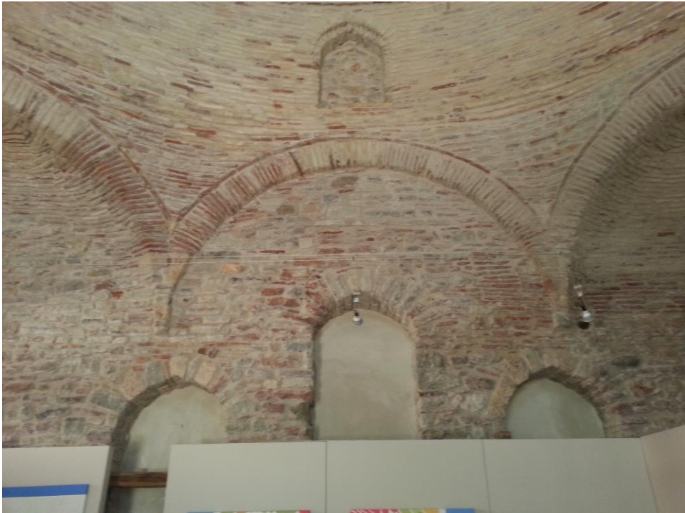
Εικ.8: Εντοιχισμένα παράθυρα ανατολικού τοίχου, Φετιχιέ Τζαμί
