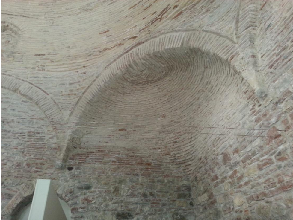
Εικ. 5: Σφαιρικό τρίγωνο ή λοφίο Φετιχιέ τζαμί
