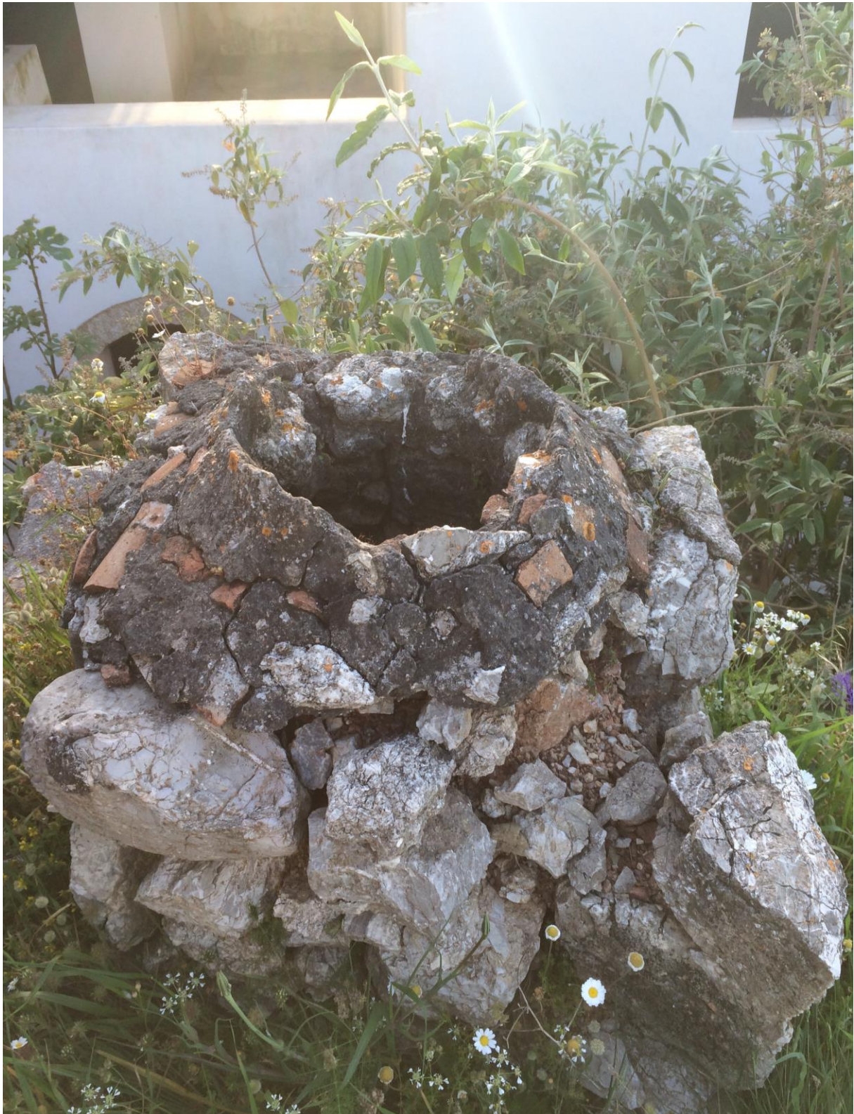
Εικόνα 3.93 Καμινάδα στην ταράτσα του ελαιοτριβείου
