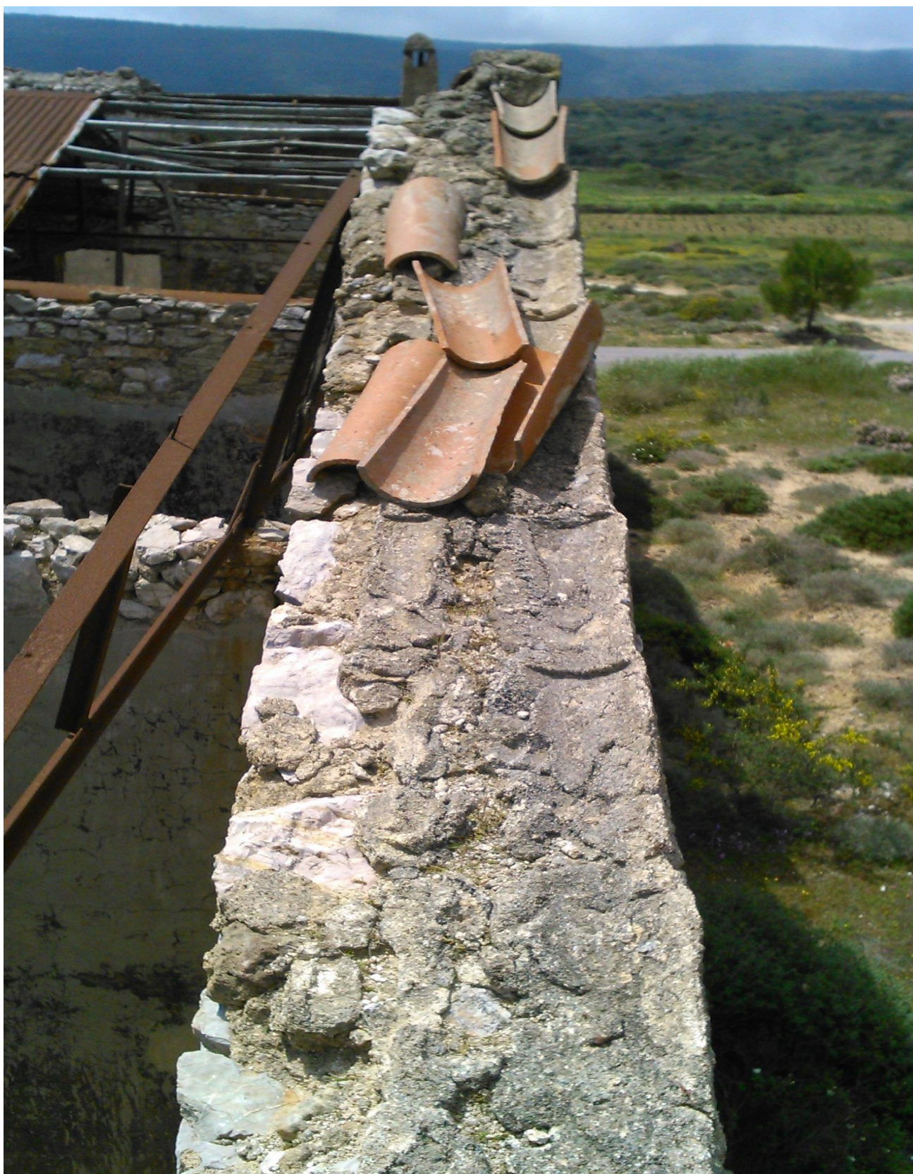
Εικόνα 3.143 Υδρορορή στέγης (συνέχεια)
