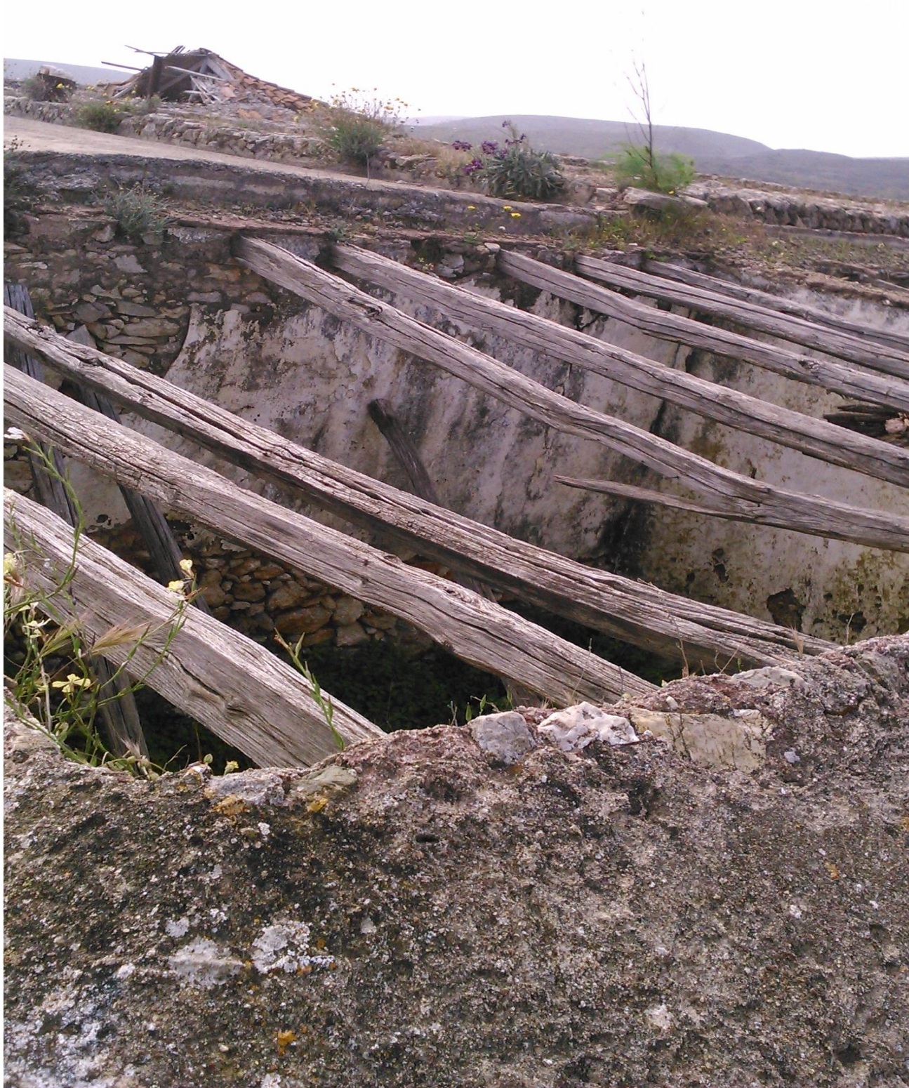
Εικόνα 3.42 Ξύλινες τεγίδες της στέγης
