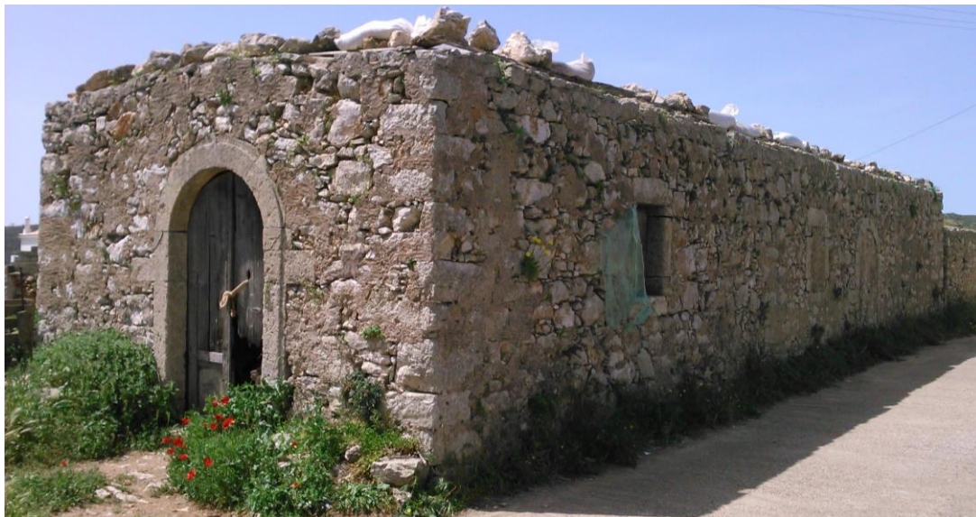
Εικόνα 3.24 Κεντρικό κτίριο ελαιοτριβείου της οικογένειας Λίμπινα στα Φριλιγκιάνικα
