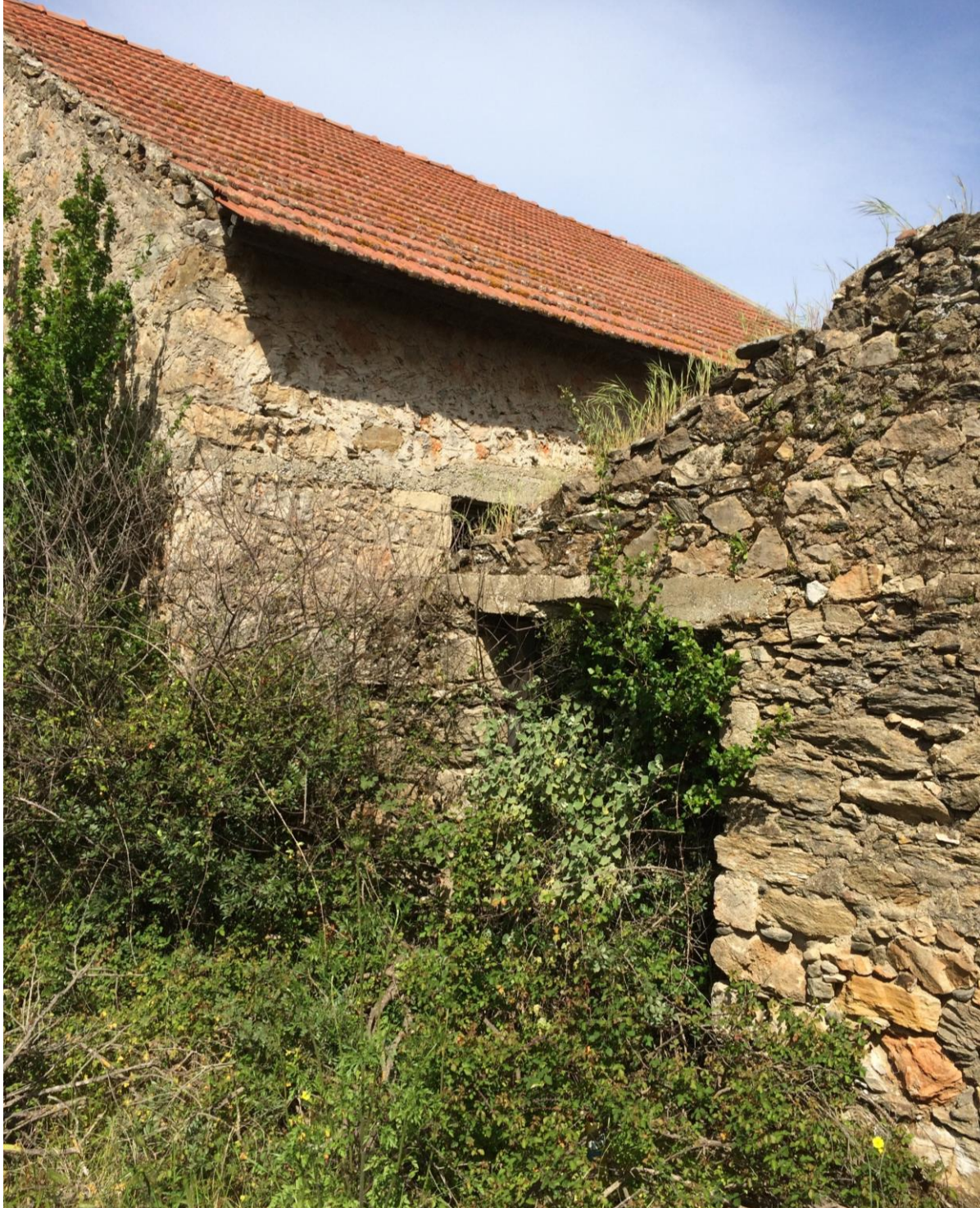
Εικόνα 3.76 Πλαϊνή όψη ελαιοτριβείου όπου φαίνεται η δίριχτη στέγη του
