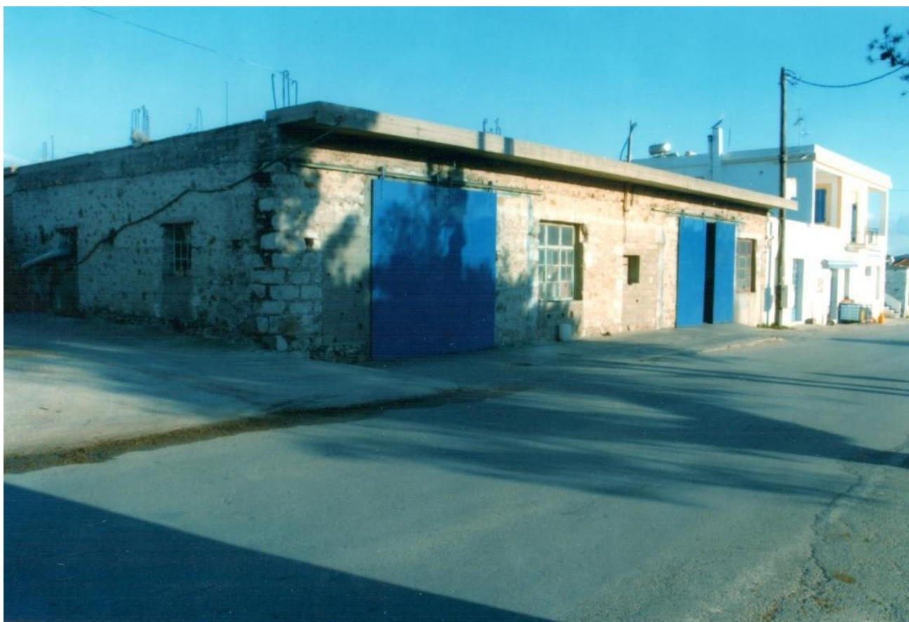
Εικόνα 3.28 Η παρούσα κατάσταση του κτιρίου του ελαιοτριβείου της οικογένειας Λουράντου στα Τσικαλαριά
