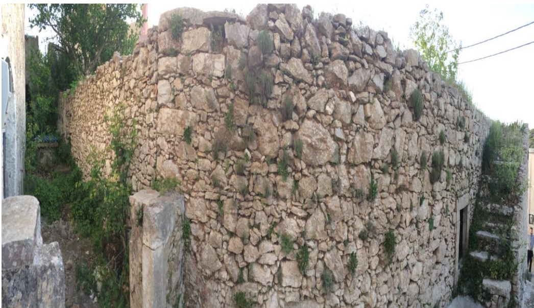
Εικόνα 3.87 Πίσω-πλαϊνή όψη ελαιοτριβείου
