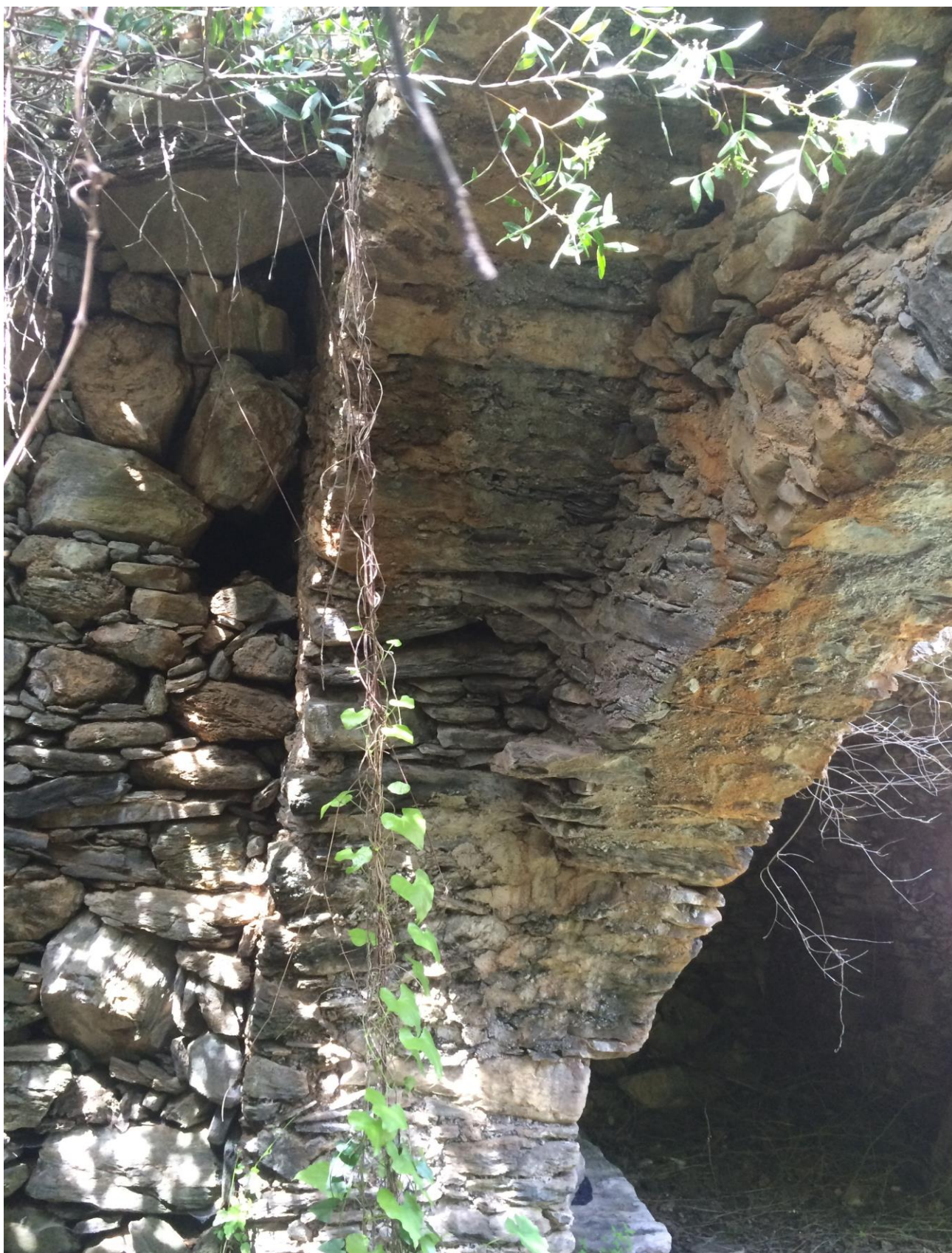
Εικόνα 3.9 Κατασκευαστική ιδιομορφία: δύο καμάρες σε μία στήριξη
