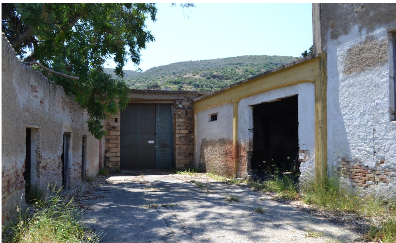
Εικόνα 3.168 Περιβάλλοντας χώρος πυρηνελαιουργείου
