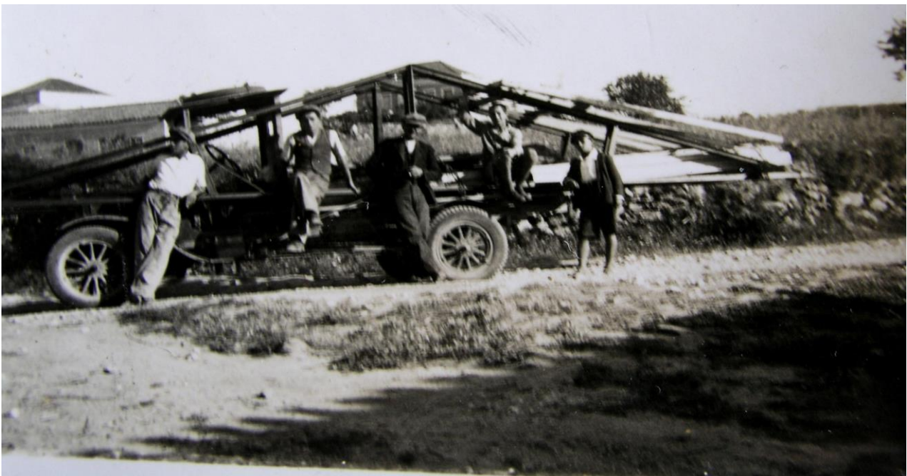
Εικόνα 3.141 Μεταφορά στέγης ελαιοτριβείου
