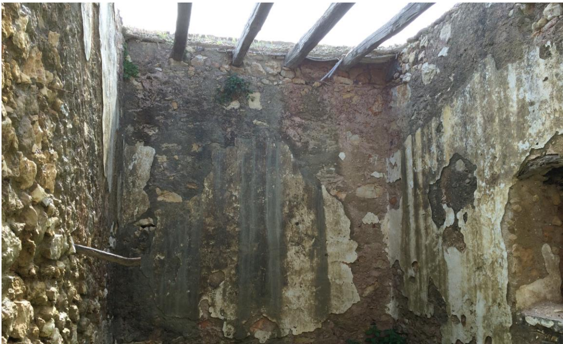
Εικόνα 3.41 Εσωτερικός χώρος κτιρίου ελαιοτριβείου
