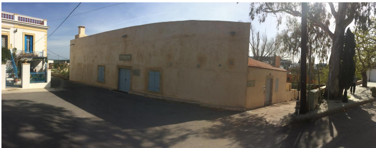
Εικόνα 3.52 Πρόσψη του ελαιοτριβείου της οικογένειας Φωτεινού στον Μυλοπόταμο όπως είναι σήμερα
