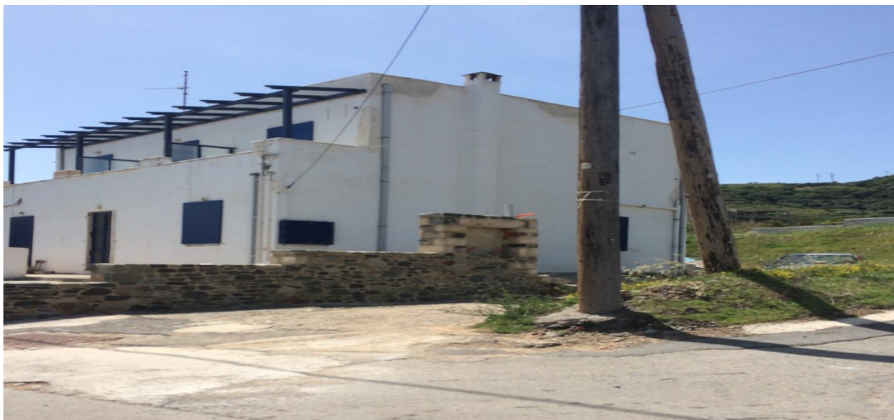
Εικόνα 5.7 Στη θέση του κτιρίου υπήρχε κεραμοποιείο της οικογένειας Ζαντιώτη στην παραλία της Αγίας Πελαγίας
