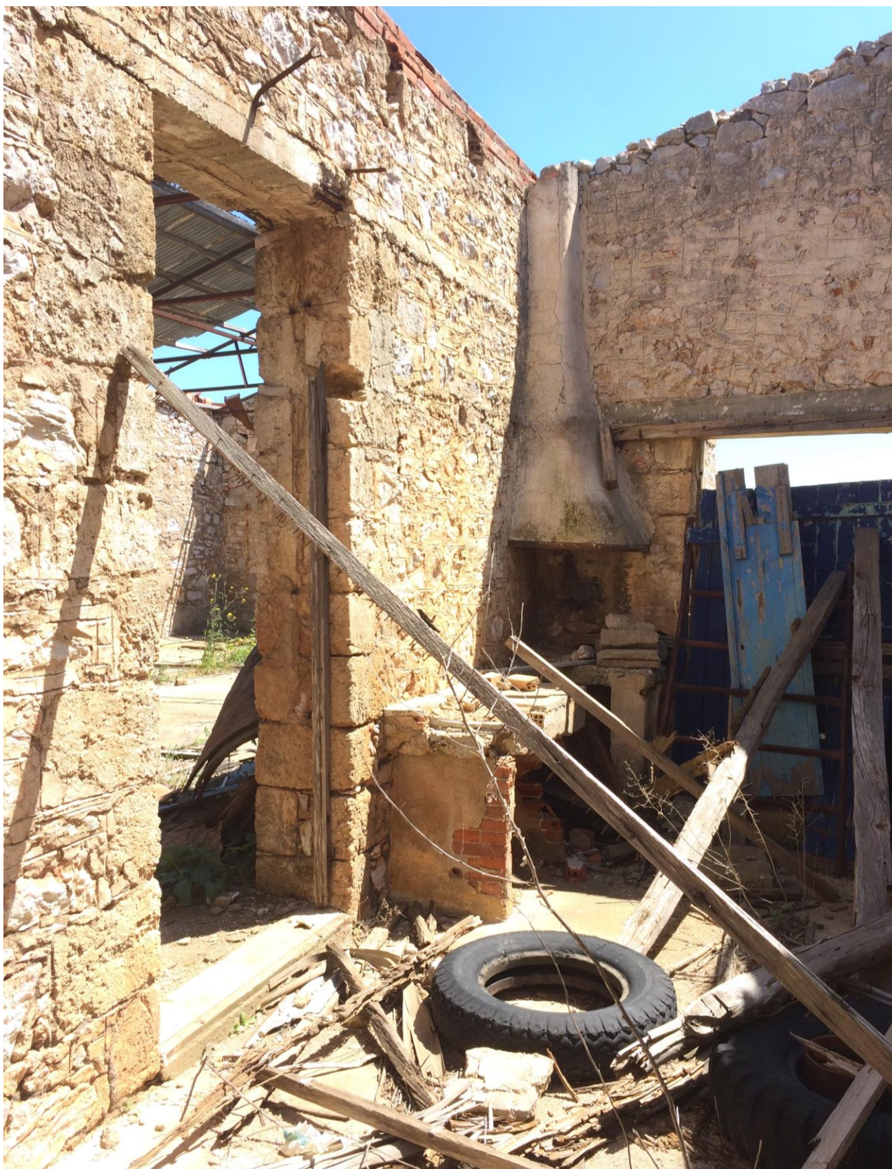
Εικόνα 3.149 Εσωτερικός χώρος – Κουζίνα
