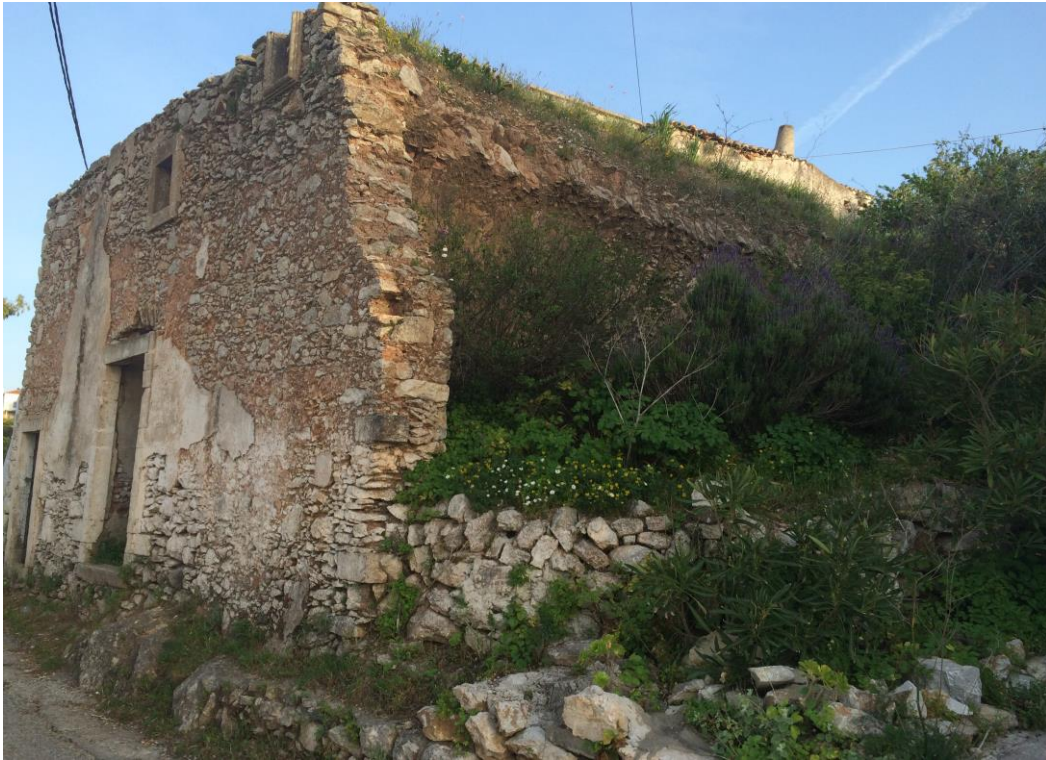
Εικόνα 3.86 Το πλαϊνό μέρος του ελαιοτριβείου όπου έχει κατεδαφιστεί
