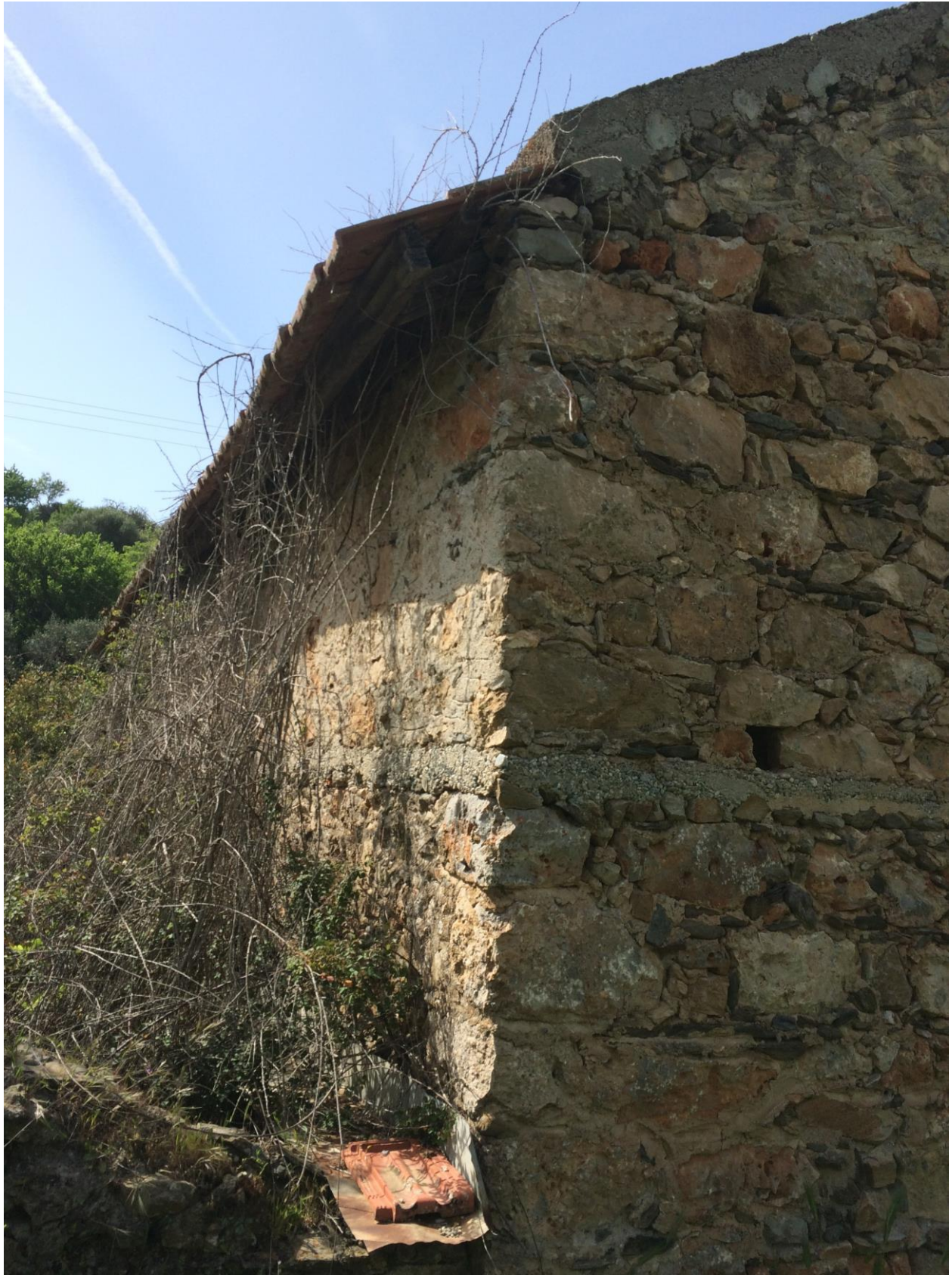
Εικόνα 3.77 Λεπτομέρειες στέγης ελαιοτριβείου
