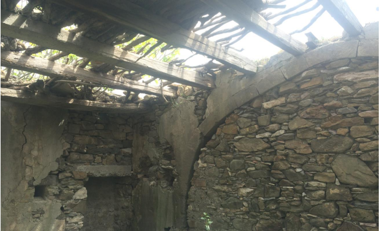
Εικόνα 3.67 Ξυλινες τεγίδες της στεγής
