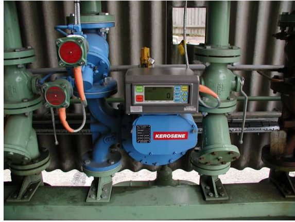
Εικ. 3.4.4: Υδραυλικό σύστημα EMR3
