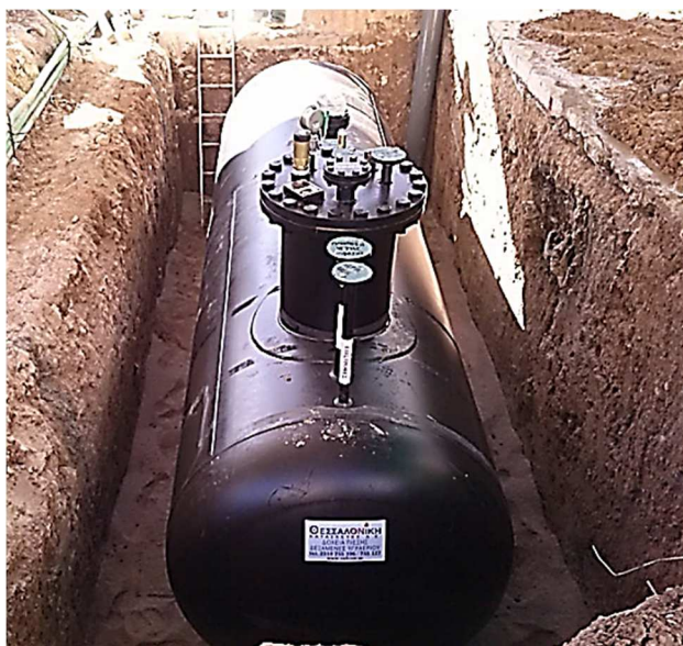
Εικ. 3.2.1: Εγκατάσταση και τοποθέτηση υπόγειας δεξαμενής υγρών καυσίμων
