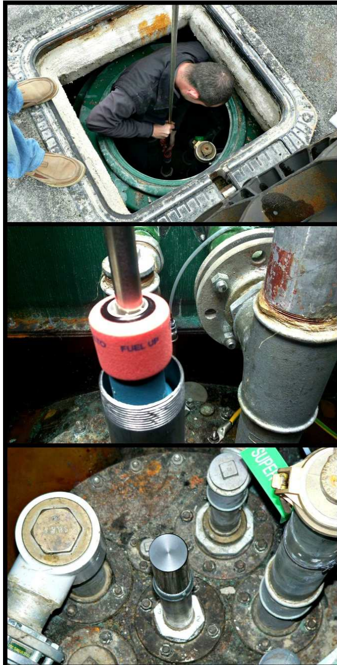
Εικ. 3.6.8: Διαδικασία εγκατάστασης ασύρματου αισθητήρα μέτρησης στάθμης
