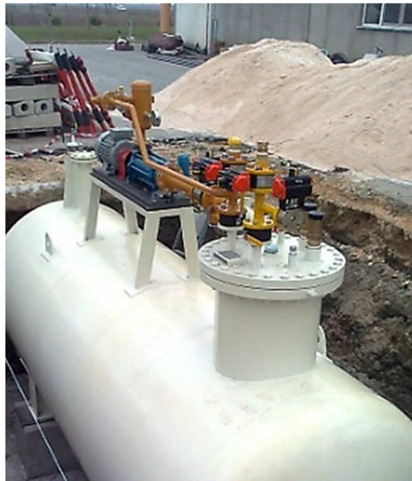
Εικ. 3.8.3: Εγκατάσταση δεξαμενής για υγραέριο LPG σε πρατήριο
