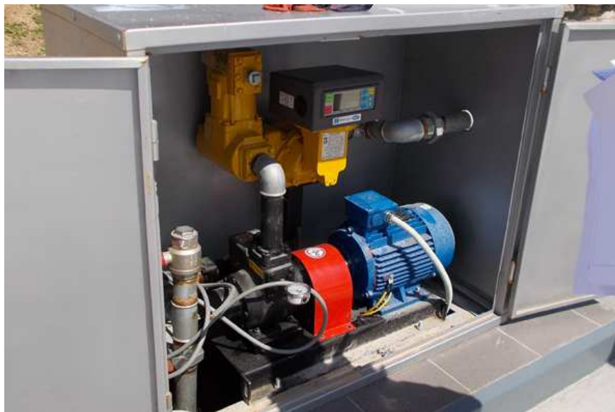
Εικ. 3.4.1: Εγκατάσταση γεμιστηρίου EMR3 σε πρατήριο υγρών καυσίμων
