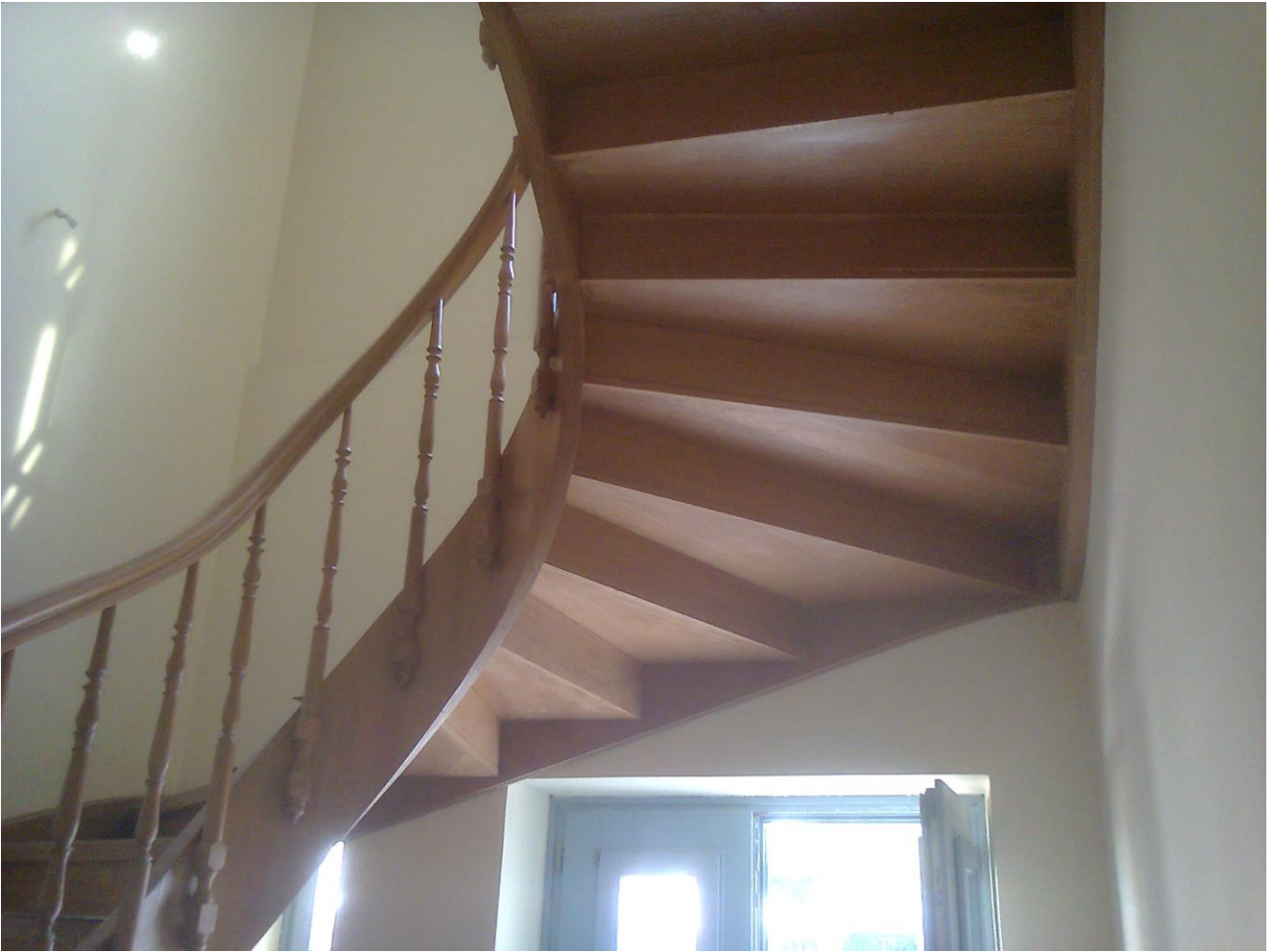
ΕΥΛΙΝΗ ΣΚΑΛΑ ΑΝΟΔΟΥ ΕΣΩΤΕΡΙΚΑ Α' ΟΡΟΦΟΥ
