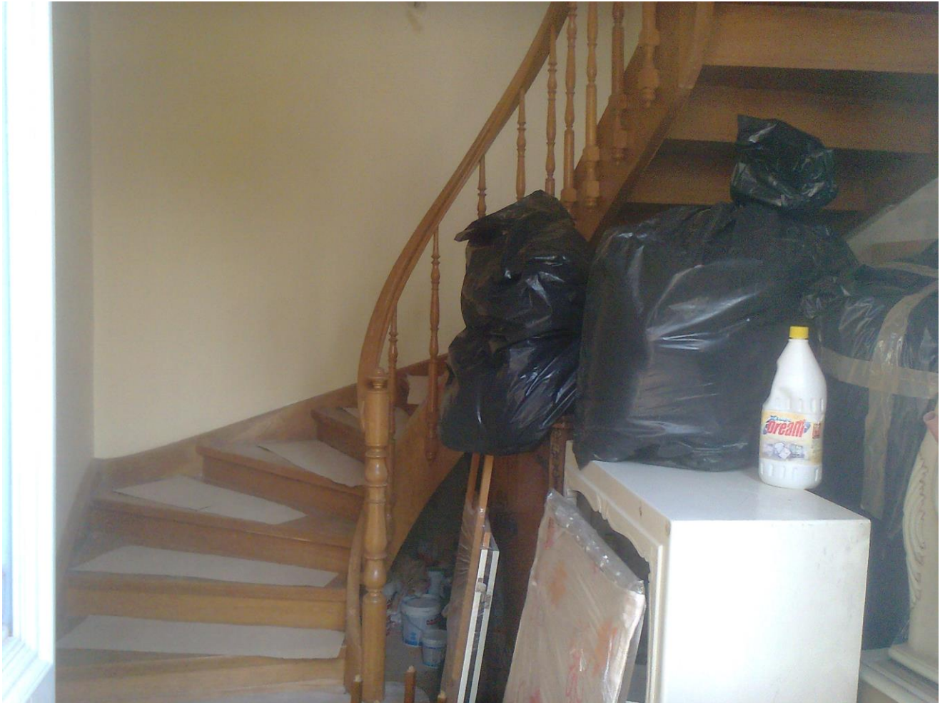
ΕΥΛΙΝΗ ΣΚΑΛΑ ΑΝΟΔΟΥ ΕΣΩΤΕΡΙΚΑ Α' ΟΡΟΦΟΥ
