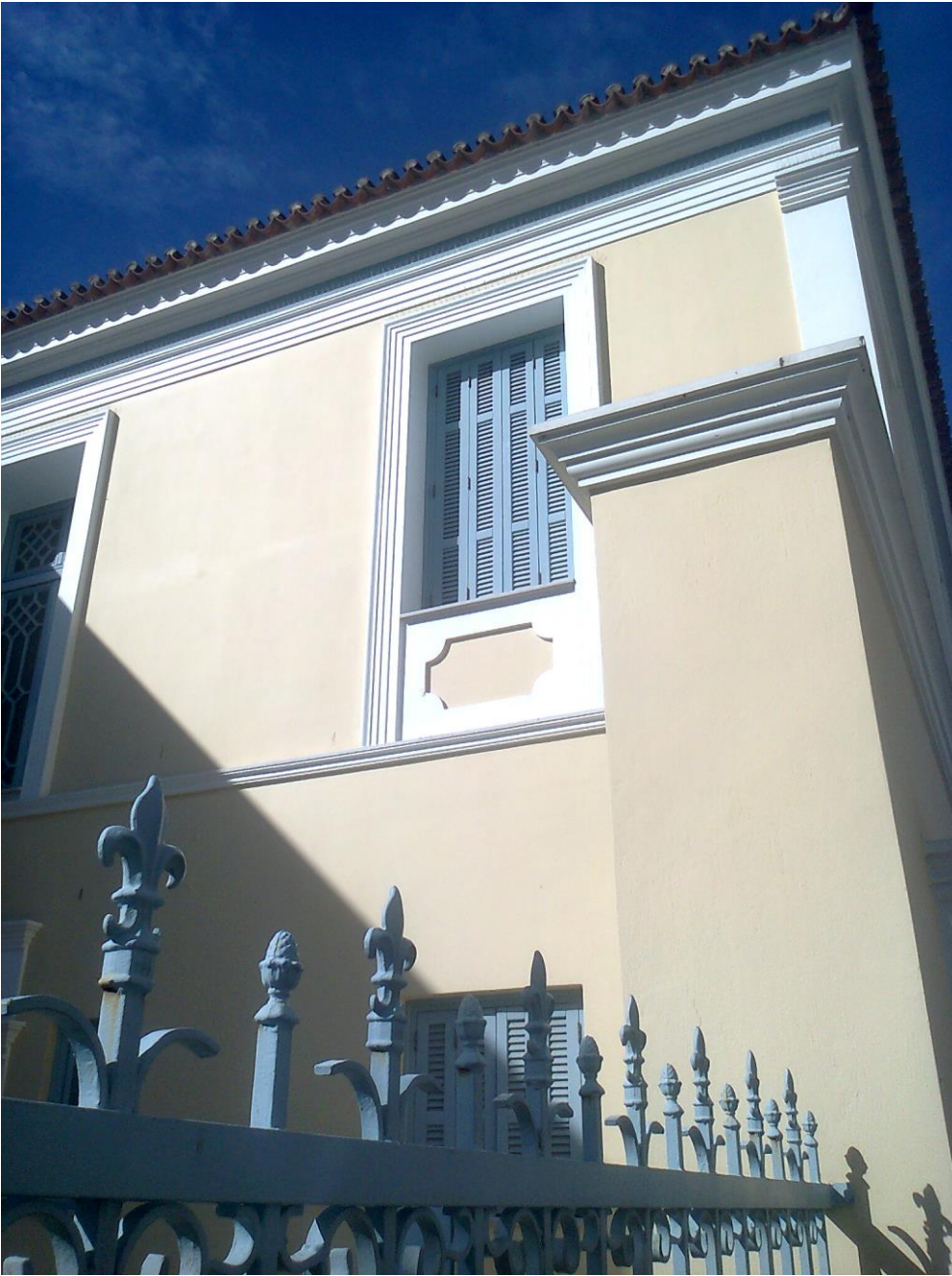
ΚΑΤΑΣΚΕΥΑΣΤΙΚΕΣ ΛΕΠΤΟΜΕΡΕΙΕΣ (ΓΕΙΣΑ ΑΝΟΙΓΜΑΤΩΝ - ΤΟΙΧΩΝ)
