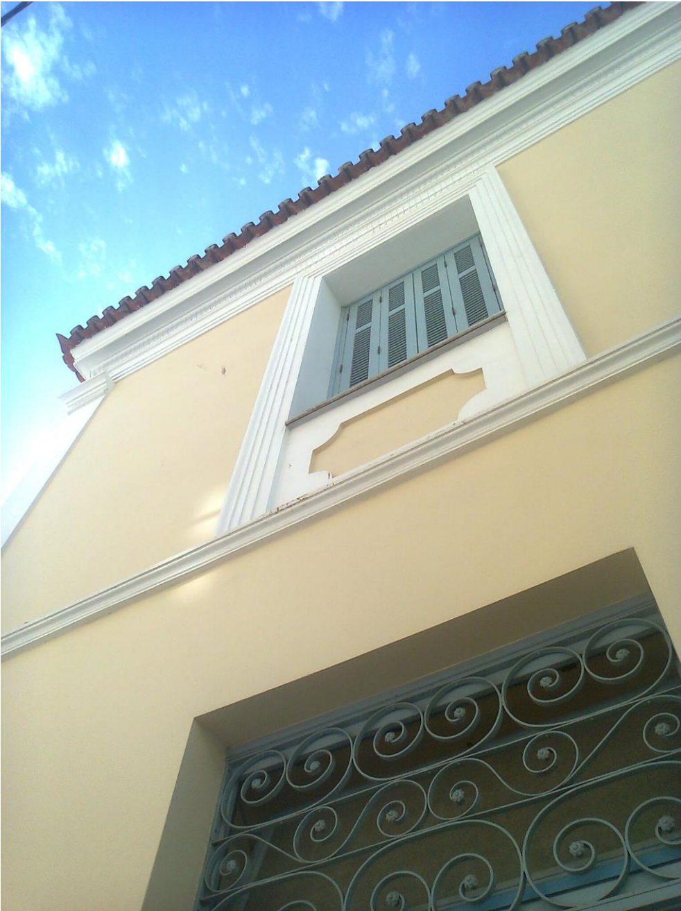
ΚΑΤΑΣΚΕΥΑΣΤΙΚΕΣ ΛΕΠΤΟΜΕΡΕΙΕΣ (ΓΕΙΣΑ ΑΝΟΙΓΜΑΤΩΝ)
