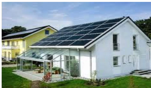
1.3 Τοποθέτηση φωτοβολταϊκών σε στέγη κατοικίας
