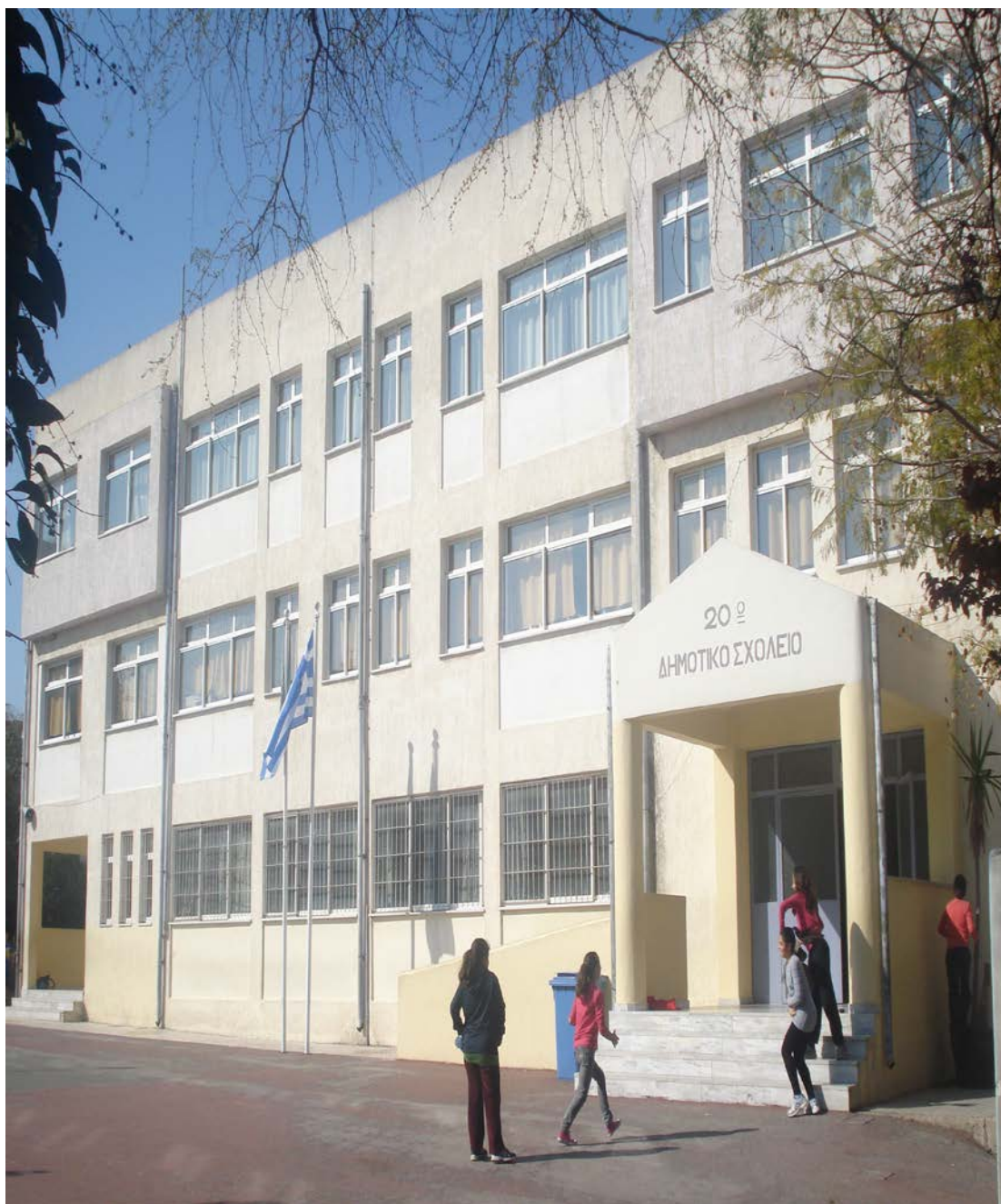
3.1 Νότια όψη σχολείου
