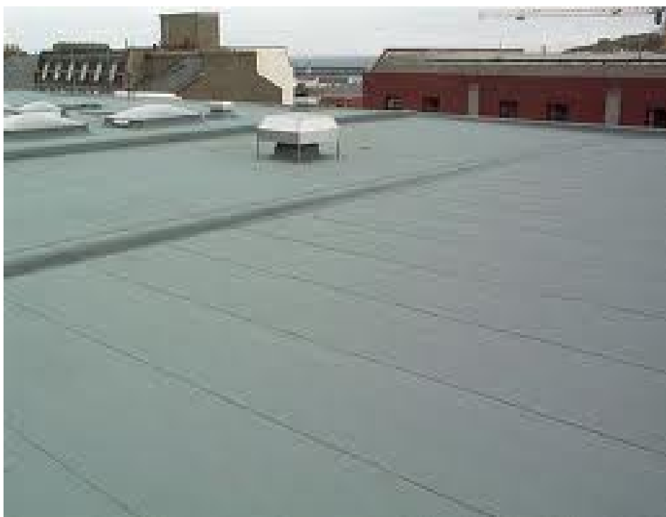
3.8 Εφαρμογή ασφαλτόπανου δώματος
