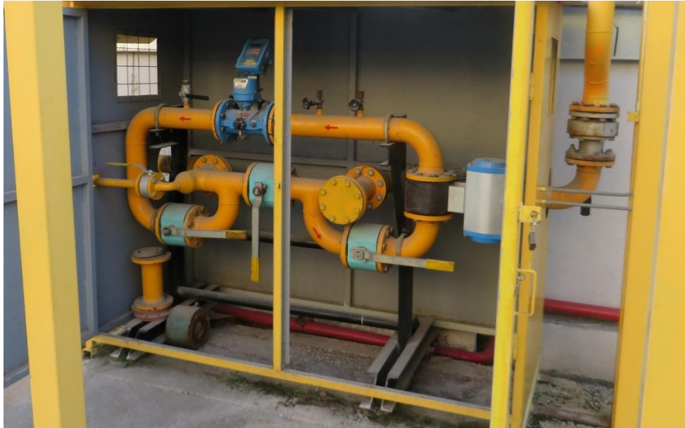
Φωτογραφία 3.2.2.1 Cabinet άφιξης παροχής Φυσικού αερίου
