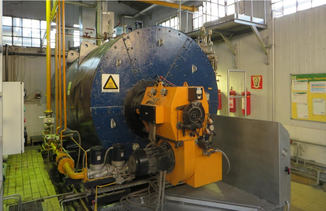
Φωτογραφία 3.2.2.4 Καζάνι παραγωγής υπέρθερμου ατμού Χρυσολούρη
