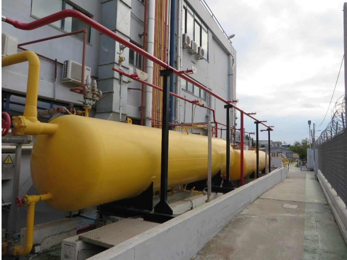
Φωτογραφία 3.2.3.5 Receiver υγράς αμμωνίας
