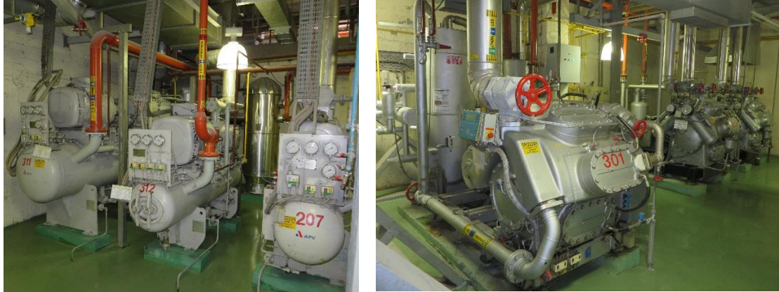
Φωτογραφία 3.2.3.3 Συμπιεστές αμμωνίας Screw (311,312,207) – Εμβολοφόροι (301-303)
