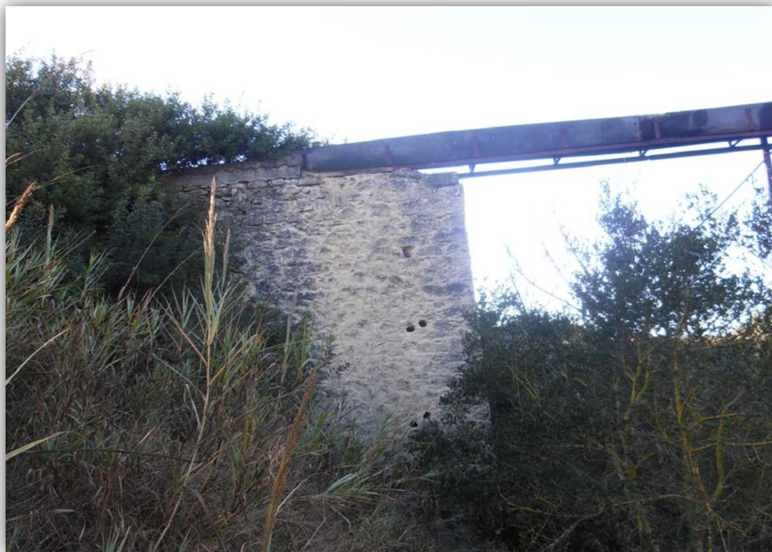
Εικόνα 55: πέτρινη υποστύλωση, υδρορροής άρδευσης «ταμπούτι»
