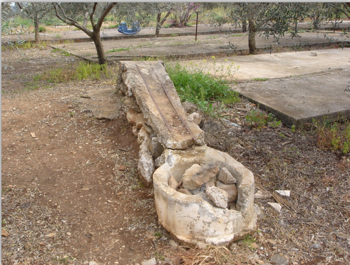
Εικόνα 35: Η «βούτα». Κατασκευή τσιμεντένια για το βούτηγμα της σουλτανίνας σε διάλυμα ποτάσας για την ξήρανση της.
