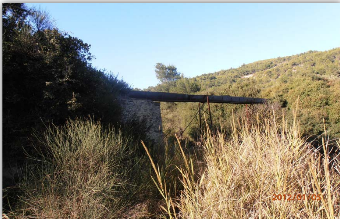
Εικόνα 54: Το μεταλλικό υδραγωγείο (ταμπούτι) που χρησιμοποιείται για την άρδευση των καλλιιεργειών
