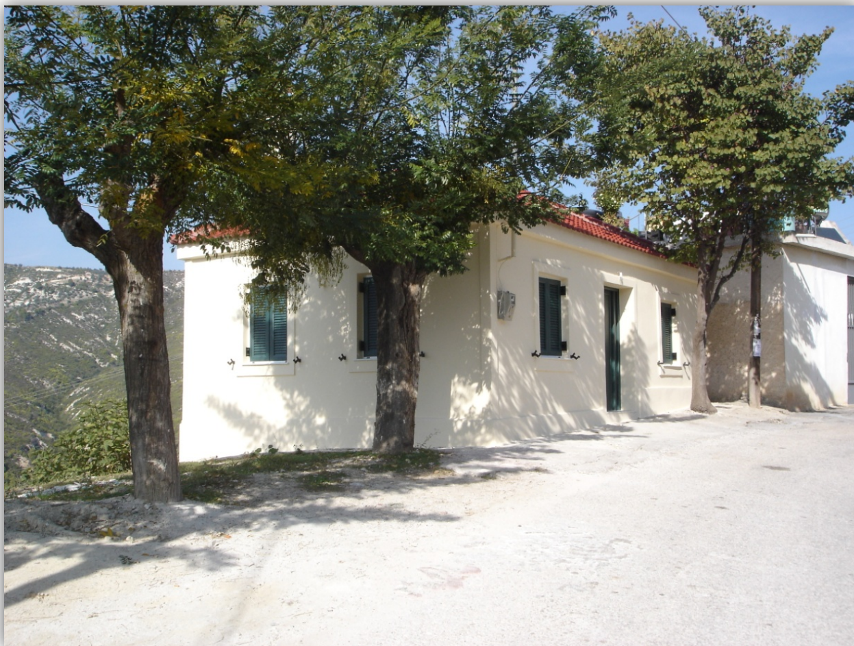
Εικόνα 60: Καλύβι που επισκευάστηκε κατάλληλα με την προαναφερόμενη μέθοδο και αποτελεί σήμερα μόνιμη κατοικία.
