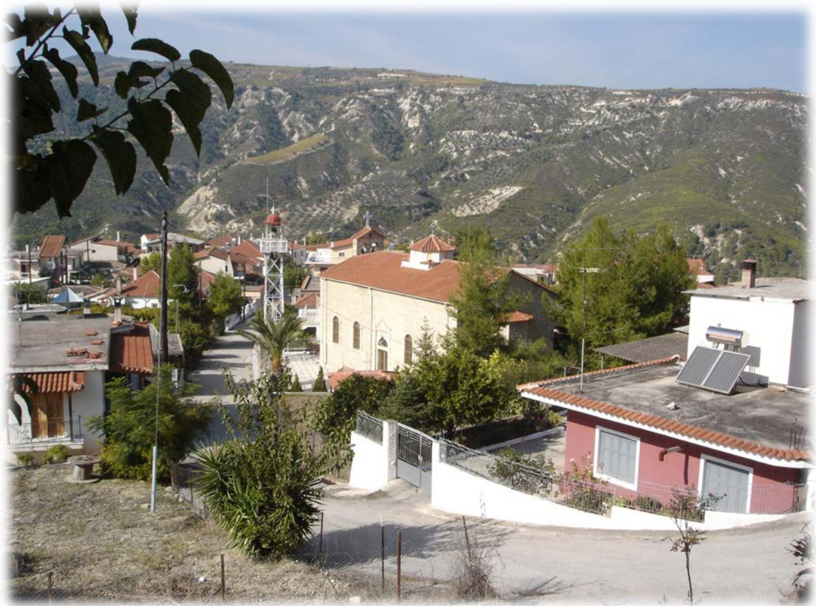
Εικόνα 3: Άποψη του κεντρικού χωριού, με την εκκλησία του Αγίου Νικολάου
