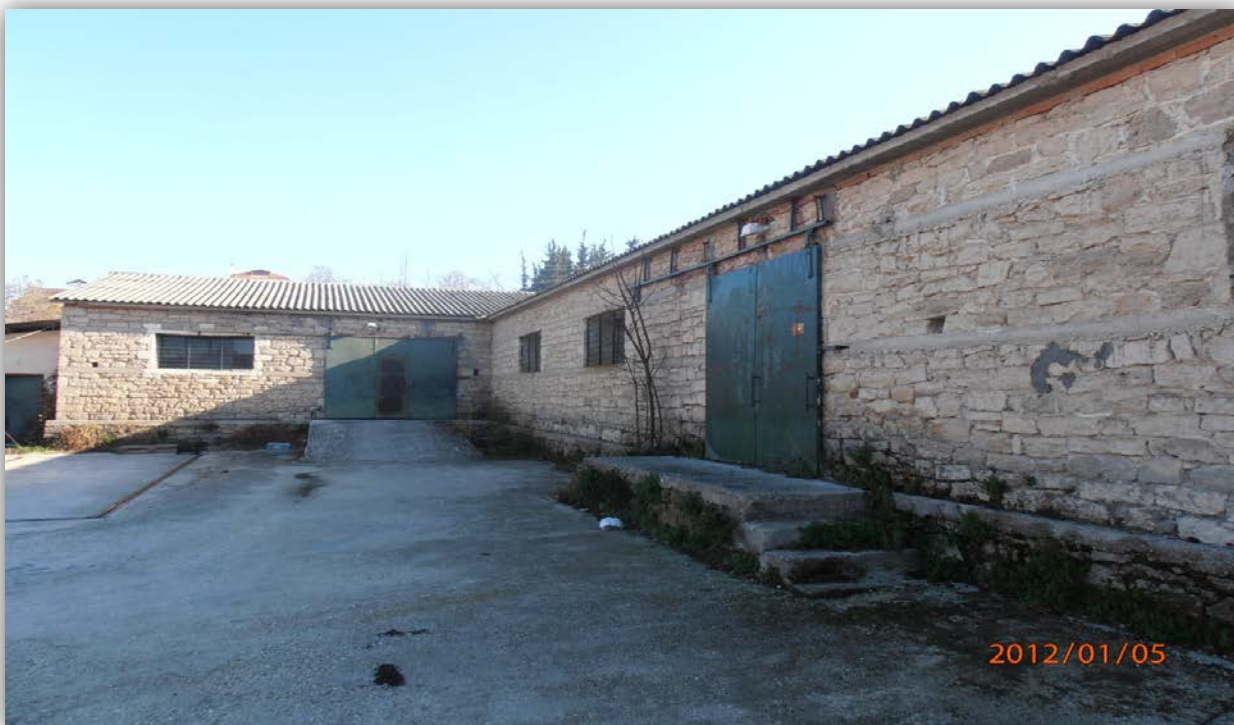
Εικόνα 52: Η πέτρινη αποθήκη του συνεταιρισμού. Κατασκευή που οφείλεται στην προσωπική εργασία των συνεταιριστών χαλκιωτών.
