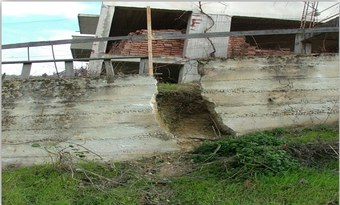
Εικόνα 66: Εκτεταμένη βλάβη σε τοίχιο στα κατάντη του χωριού λόγω του φαινομένου της κατολίστησης.
