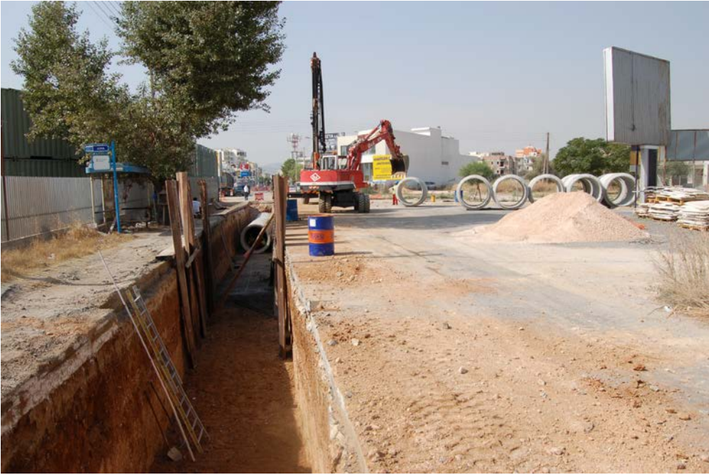
Εικόνα 95 Εργασίες Δικτύου Όμβριων στη Λεωφ. Καραμανλή Πηγή: Αρχείο Φωτογράφων Δήμου Αχαρνών
