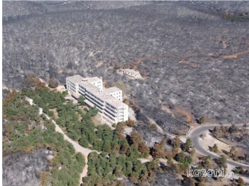
Εικόνα 81 Αεροφωτογραφία μετά την Καταστροφική Πύρκαγια Πηγή : www.kazani.gr
