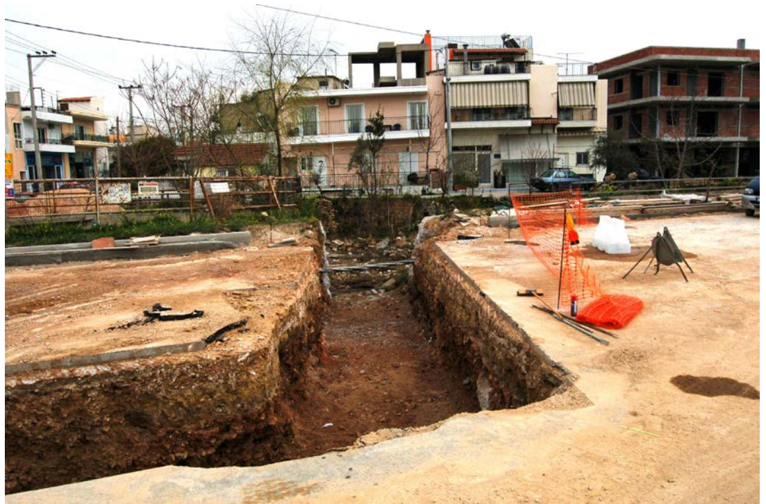
Εικόνα 96 Εργασίες Δικτύου Όμβριων στην οδό Εθνικής Αντιστάσεως & Αγ. Διονυσίου Πηγή: Αρχείο Φωτογράφων Δήμου Αχαρνών
