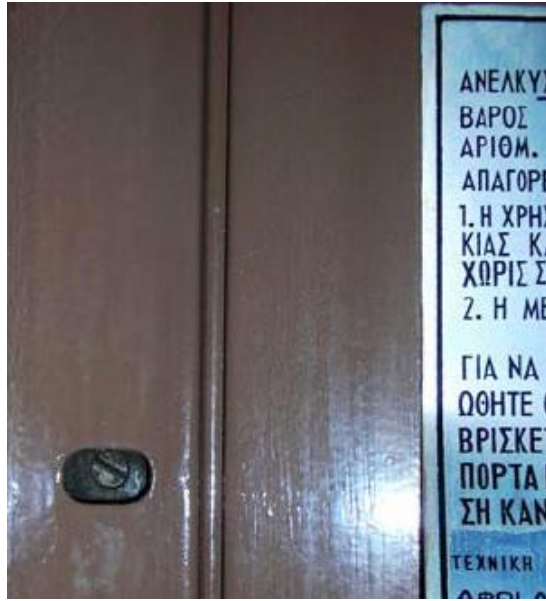
Εικόνα 6.7: Πόρτα που ανοίγει με κατσαβίδι
