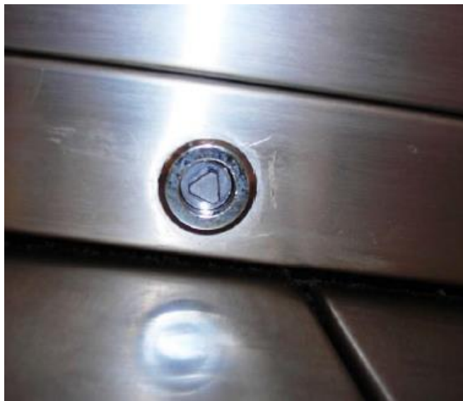
Εικόνα 6.8: Τρίγωνη υποδοχή σε συρόμενη πόρτα
