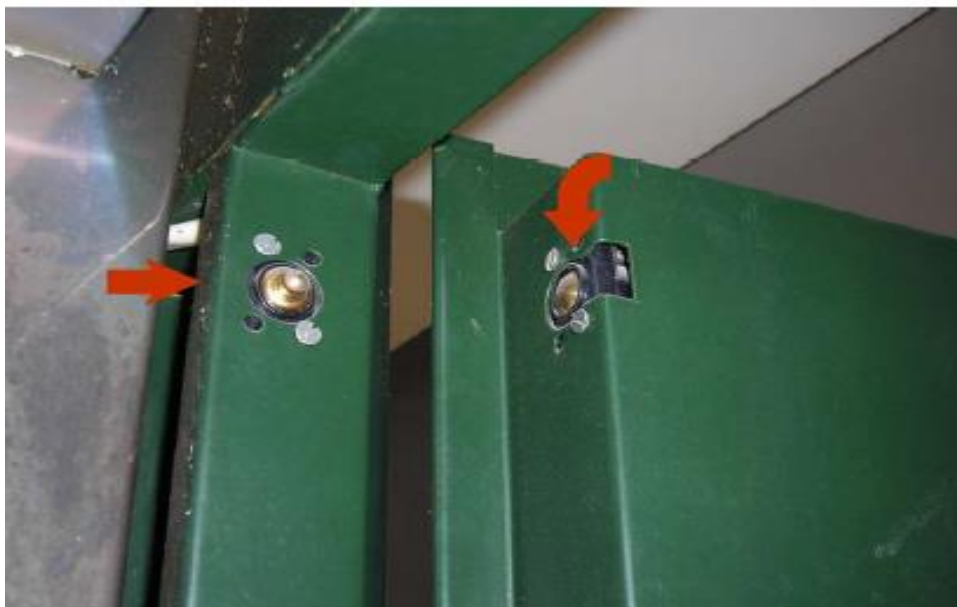
Εικόνα 6.10: Σημεία εργασιών απεγκλωβισμού
