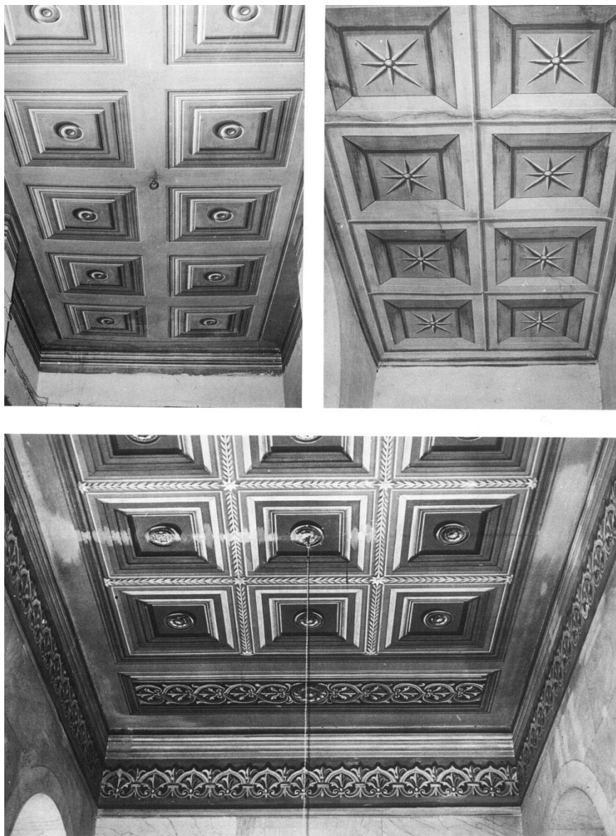
Εικόνα 18. Φατνωματικές οροφές (πηγή: Ερμούπολη, Τραυλός Ι. – Κόκκου Α. Εκδ. Εμπορικής Τράπεζας της Ελλάδος, Αθήνα 1980)
