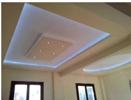
Εικόνα 52. Πρόταση γυψοσανίδας με κρυφό φωτισμό
