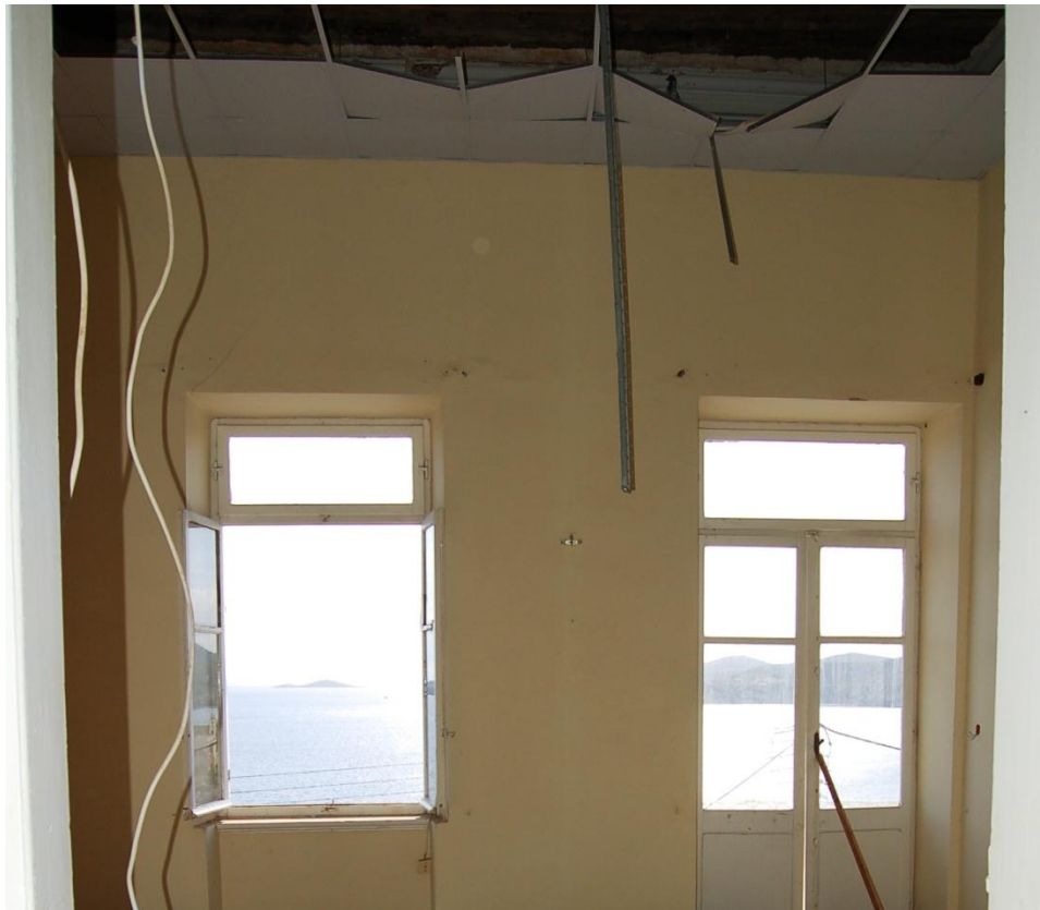
Εικόνα 42. Οροφή δωματίου στον Β' όροφο του κτηρίου. (πηγή: αρχείο Ισιδώρειο Ίδρυμα)
