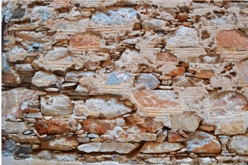
Εικόνα 31. Λιθοδομή εξωτερικού τοίχου (πηγή: προσωπικό αρχείο)
