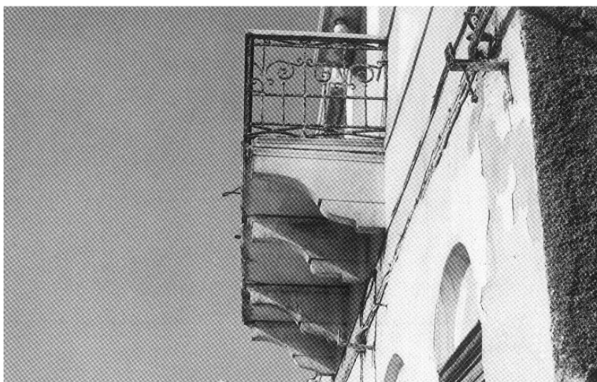
Εικόνα 16. Μπαλκόνια με ξύλινα και μαρμάρινα φουρούσια (πηγή: Ερμούπολη, Τραυλός Ι. – Κόκκου Α. Εκδ. Εμπορικής Τράπεζας της Ελλάδος, Αθήνα 1980)
