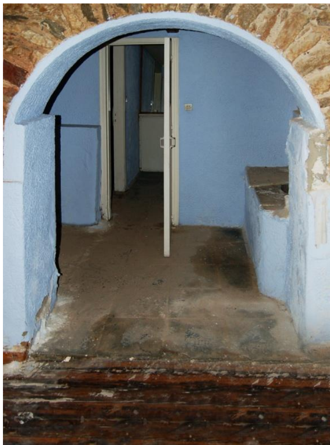
Εικόνα 32. Καμάρα (πηγή: αρχείο Ισιδώρειο Ίδρυμα)
