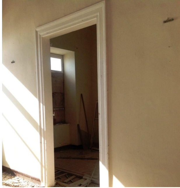
Εικόνα 44 Πόρτα . (πηγή: αρχείο Ισιδώρειο Ίδρυμα)
