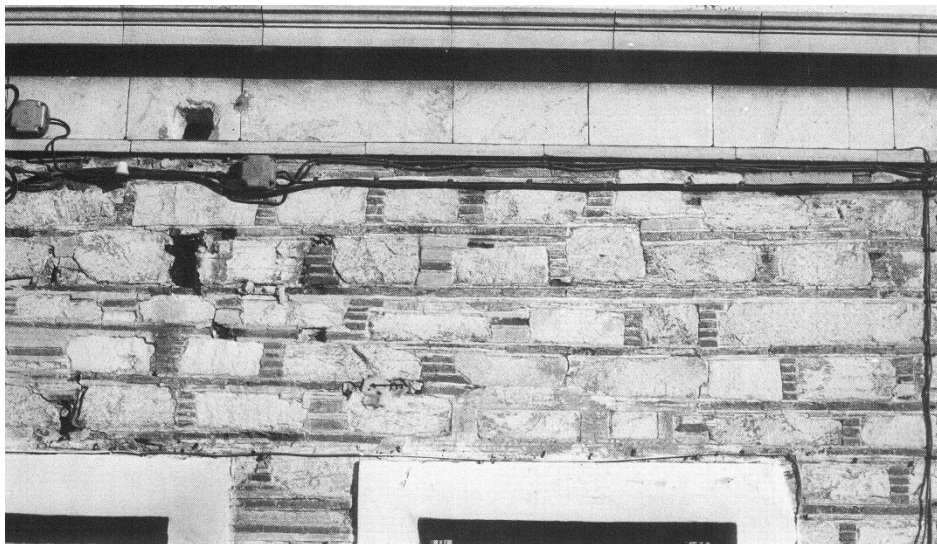
Εικόνα 12. Δείγματα τοιχοδομίας με κονίαμα ή τούβλα στους αρμούς (πηγή: Ερμούπολη, Τραυλός Ι. – Κόκκου Α. Εκδ. Εμπορικής Τράπεζας της Ελλάδος, Αθήνα 1980)
