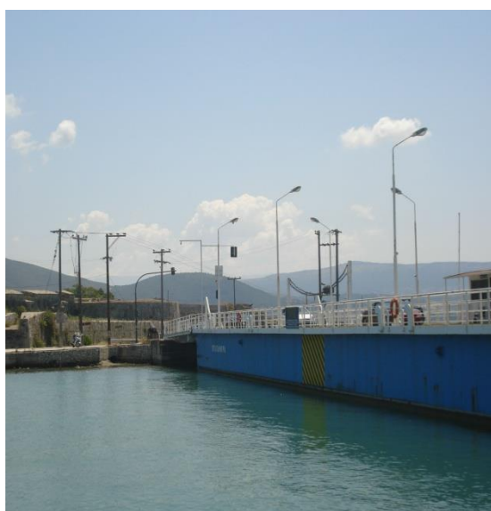
Φωτ. 16: Η πλωτή γέφυρα της Λευκάδας
