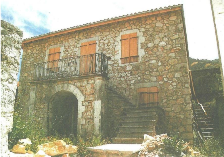
Φωτ. 109: Το κτίριο όπου στεγάστηκε η πρώτη σχολή κεντήματος της Καρυάς με την εποπτεία της Μαρίας Κουτσοχέρω
