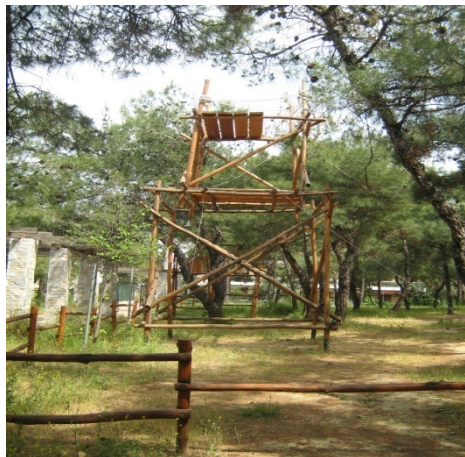
Φ3.3.6 Κατασκευή των προσκόπων Χολαργού.
