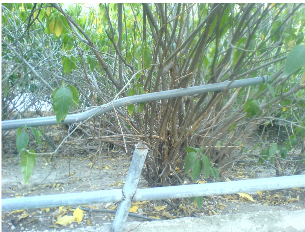
Φ4.4.6 Στηθαίο μεταλλικό.
