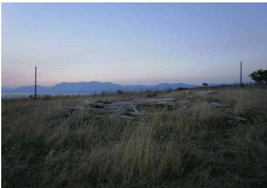
Εικόνα 44 : Χώρος έτοιμος προς θεμελίωση.
