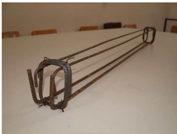
Εικόνα 15: Οπλισμός δοκού (κλωβός)
