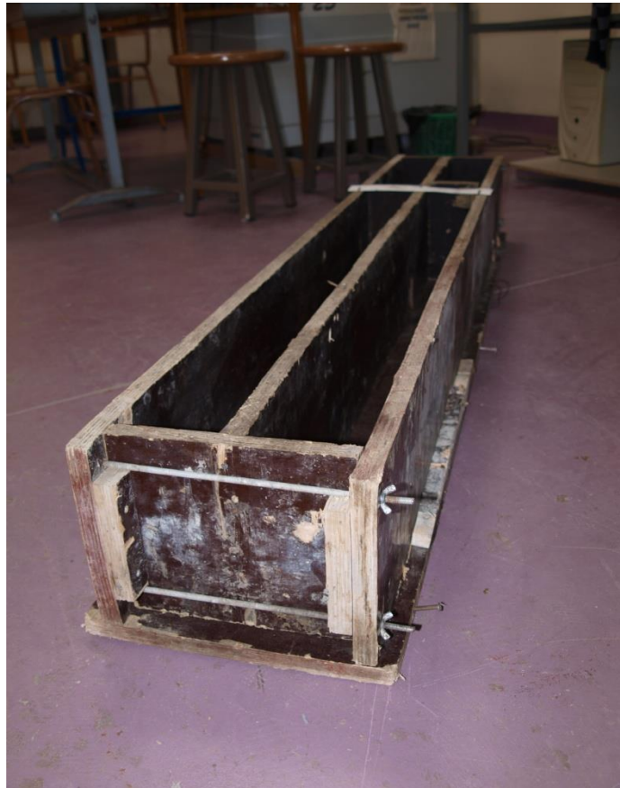
Εικόνα 13: Καλούπια σκυροδέτησης δοκού
