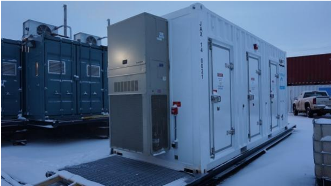
Εικόνα 27 Μεγάλης κλίμακας συστοιχίες συσσωρευτών για μεγάλη παραγωγή ηλιακής ενέργειας
