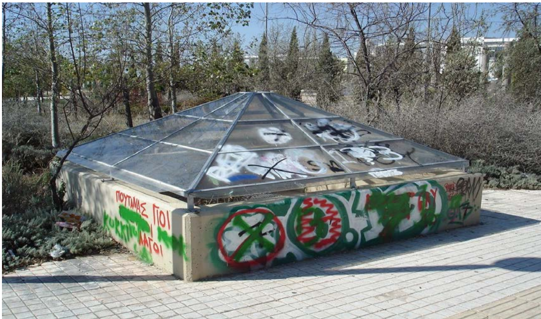
Εικόνα 24: Η σημερινή κατάσταση των προστατευτικών καλυμμάτων του Αδριάνειου υδραγωγείου (πηγή: προσωπική λήψη).
