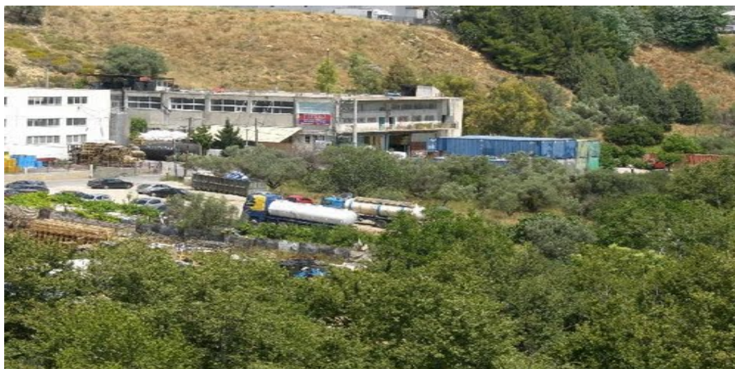
Εικόνα 21: Αυθαίρετες βιομηχανικές εγκαταστάσεις στην Α΄ Ζώνη Προστασίας. (πηγή:προσωπική λήψη)
