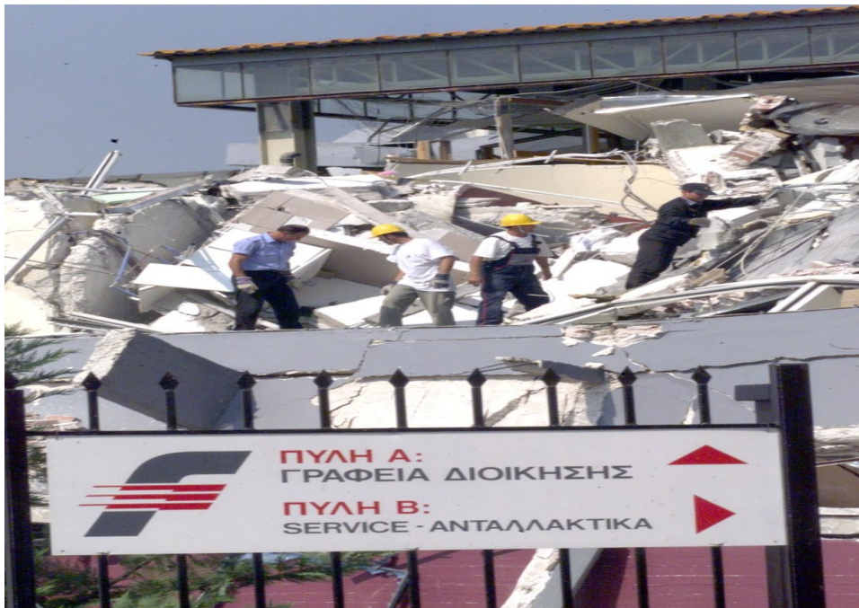
Εικόνα 33 : Εργοστάσιο «ΦΟΥΡΛΗΣ», αμέσως μετά την κατάρρευση του. (πηγή: www.tovima.gr )
