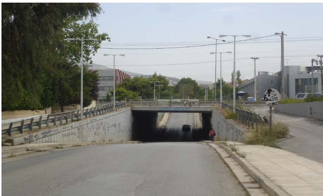
Εικόνα 29: Υπόγεια διάβαση επί της οδού Τροιζηνίας. (πηγή: προσωπική λήψη)
