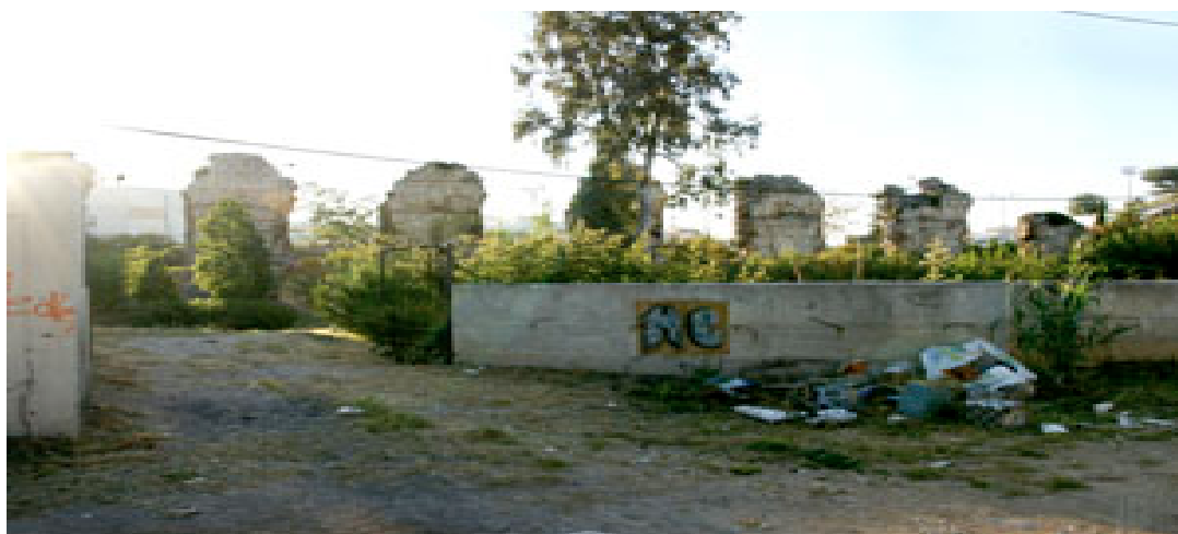
Εικόνα 25: Διάσπαρτα σκουπίδια στο Αδριάνειο υδραγωγείο και παντελής έλλειψη φύλαξης του αρχαιολογικού χώρου. (πηγή: www.zonews.gr ).
