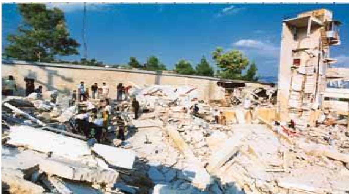
Εικόνα 34: Το εργοστάσιο Ricomex μετά την κατάρρευσή του. (πηγή: www.tovima.gr )
