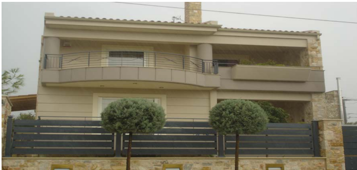
Εικόνα 23: Νέα κατοικία στην Πολεοδομική Ενότητα Γράμμος Φοίνικας. Χαρακτηριστικό παράδειγμα αρχιτεκτονικής στη συνοικία των Αδαμών. (πηγή: προσωπική λήψη)
