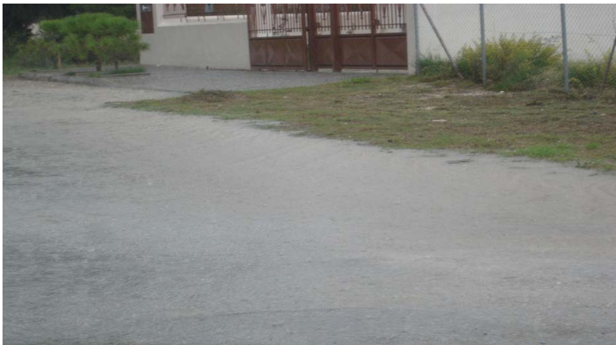
Εικόνα 26: Πλημμυρισμένος δρόμος στις Αδάμες κατά τη διάρκεια βροχόπτωσης. (πηγή :προσωπική λήψη)
