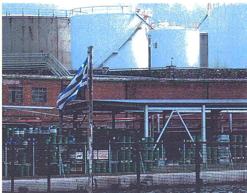
Φωτο. 5: ΕΓΚΑΤΑΣΤΑΣΕΙΣ MOBIL OIL HELLAS
