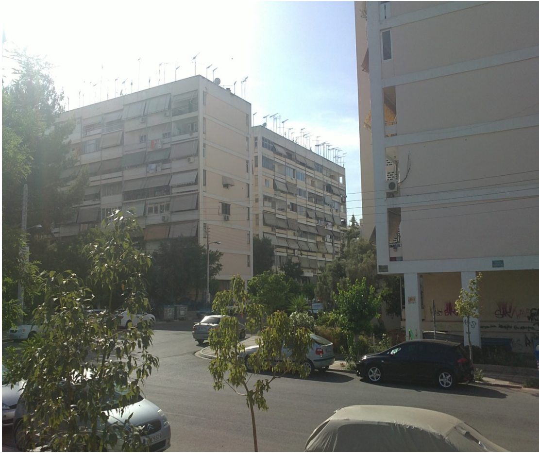
Εικόνα 25: Σε αυτήν την φωτογραφία μιλάμε για τον ορισμό της μετατροπής του εξώστη σε κλειστό χώρο και μάλιστα σχεδόν απέναντι από το Δημαρχείο. Δεν κάναμε σμίκρυνση της φωτογραφίας για να φανούν όσο το δυνατόν περισσότεροι κλεισμένοι εξώστες. Τα κτίρια αυτά είναι οι προσφυγικές-εργατικές κατοικίες (commieblocks) της Δραπετσώνας και χρίστηκαν στην δεκαετία του '70.
