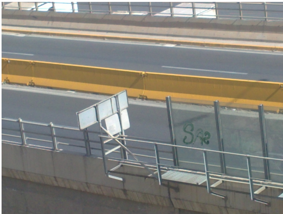
Εικόνες 100-101: ελλειψής περίφραξη του περιφερειακού δρόμου για την αποφυγή της ηχορύπανσης καθ' ότι υπάρχουν κενά.
