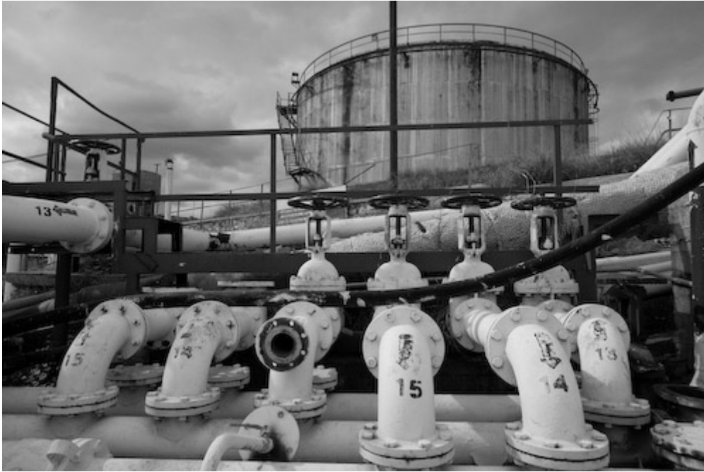
Εικόνα 66: παλιές εγκαταστάσεις BP-Fina στη Δραπετσώνα. Ο χώρος -που πρέπει να έχει κλείσει πάνω από 15 χρόνια- βρίσκεται λίγο πριν την ιχθυόσκαλα Κερατσινίου και συγκεκριμένα δίπλα στην ΑΓΕΤ Ηρακλής.
