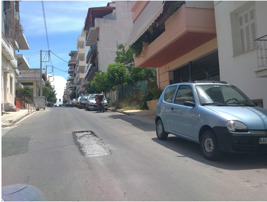
Εικόνα 105: Στην οδό Μάρκου Μπότσαρη βλέπουμε ότι λείπει ολόκληρο κομμάτι από τον δρόμο. Εγκληματική αμέλεια που μπορεί να αποβεί θανατηφόρα εάν κάποιο μηχανάκι πέσει μέσα.
