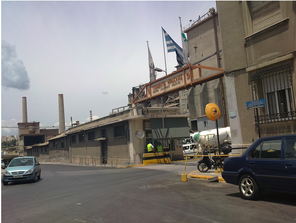
ΕΙΚΟΝΑ 71: Είσοδος εγκαταστάσεων ΑΓΕΤ ΗΡΑΚΛΗΣ που βρίσκεται στην διασταύρωση των οδών Κοντοπούλου και ΓΡ.Λαμπράκη.
