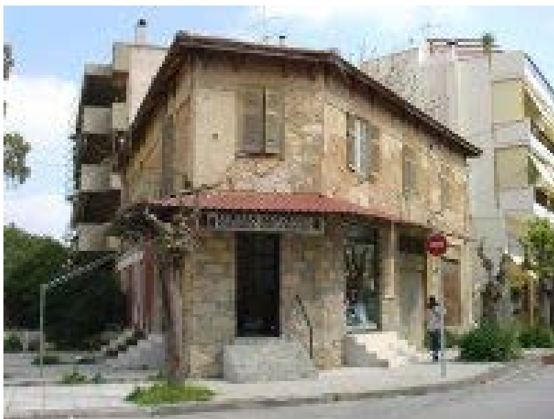
Εικόνα 48: Διώροφο λίθινο σπίτι στη Νέα Φιλαδέλφεια.
