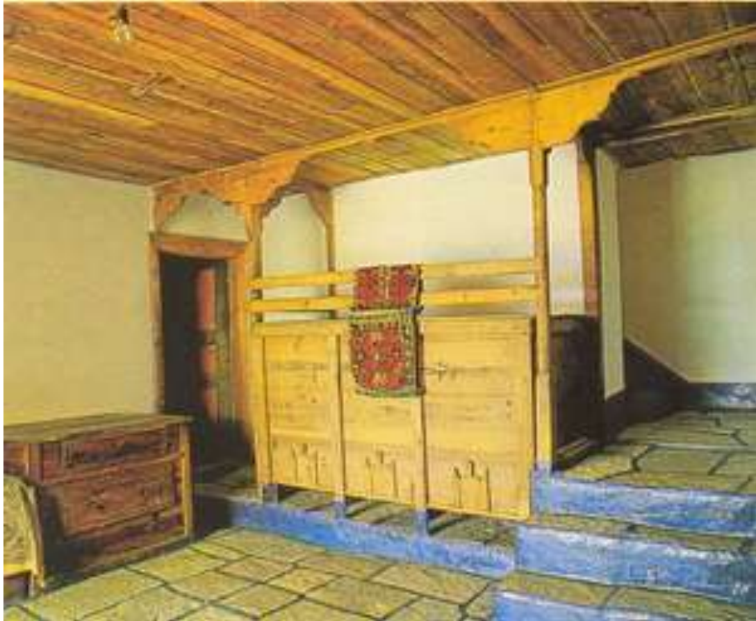
Εικόνα 12 Χαγιάτι. Δάπεδο από ορθογώνιες μαύρες πλάκες. Οι αρμοί είναι βαμμένοι με χρώμα.
