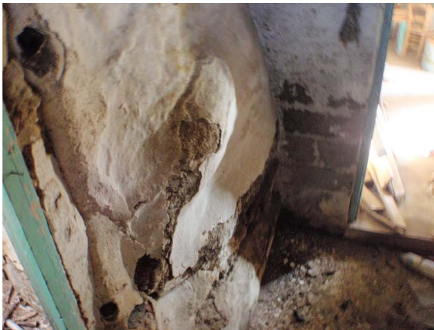
Εικόνα 6-11. Ο βράχος που προαναφέραμε και οι εκρήξεις που έχουν προκληθεί με συνέπεια την αποκόλληση του σοβά.
