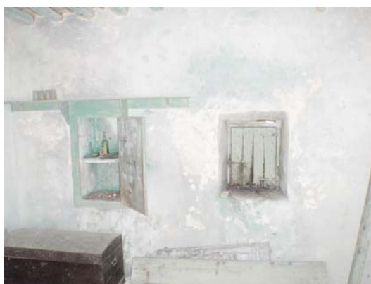
Εικόνα 6-7. Εσωτερικό ξύλινο κούφωμα χωρίς τζαμι.
