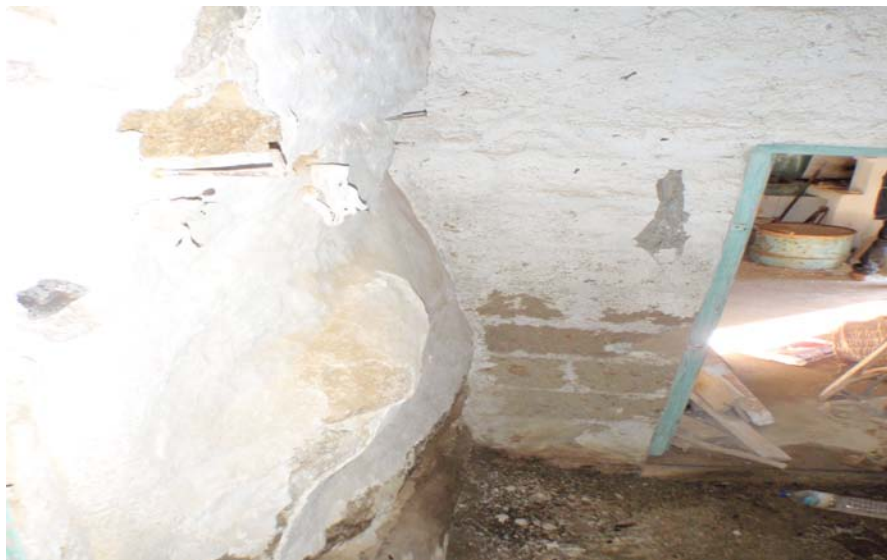
Εικόνα 6-13. Η μορφή του δαπέδου και η υγρασία που βγάζει στο χώρο.
