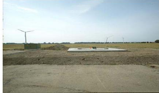
Κατασκευή βάσεων στήριξης
