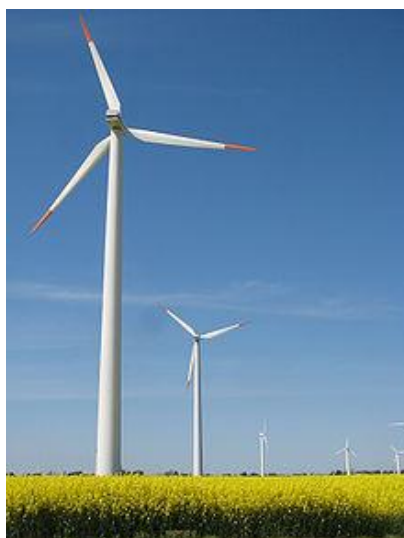
Εικ.1.2: Αιολικό πάρκο στο Χόλσταϊν της Γερμανίας (Πηγή: ιστοχώρος ΒΙΚΙΠΑΙΔΕΙΑ)
