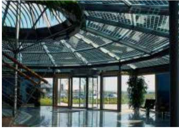
Εικ 2.11 Εφαρμογή Φωτοβολταϊκών σε Εμπορικό Κέντρο
