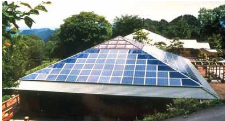
Εικ 2.14 Ενσωματωμένα Φ/Β στοιχεία σε κεκλιμένη στέγη
