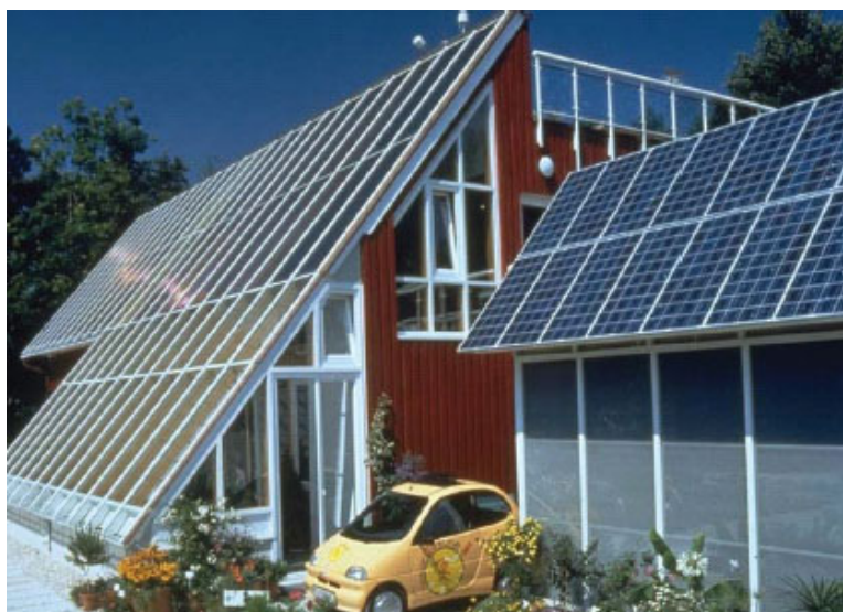
Εικ 2.8 Φωτοβολταϊκά σε φεγγίτες και παράθυρα
