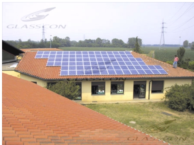
Εικ 3.4 Τοποθέτηση μη ενσωματωμένων Φ/Β σε κεραμοσκεπή
