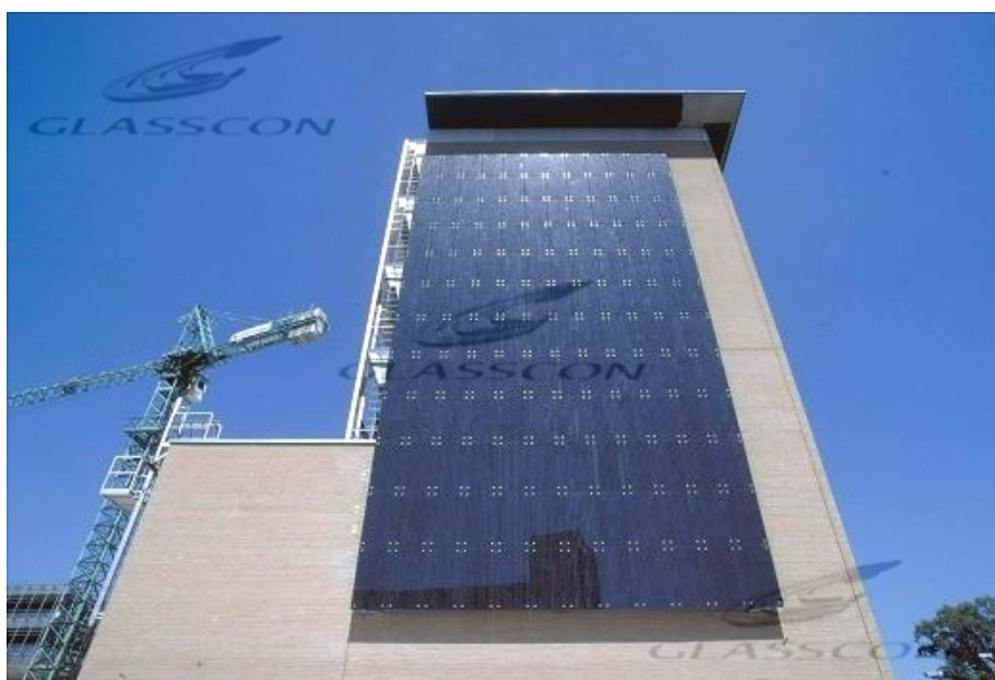
Εικ 3.12 Τοποθέτηση Φ/Β παράλληλα στην πρόσοψη πολυόροφου κτιρίου
