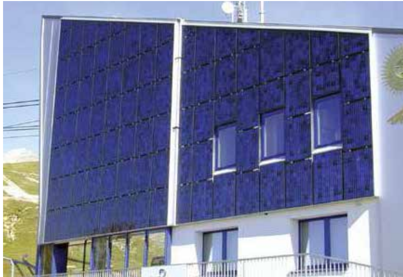
Εικ 3.9 Ενσωματωμένα Φ/Β σε πρόσοψη
