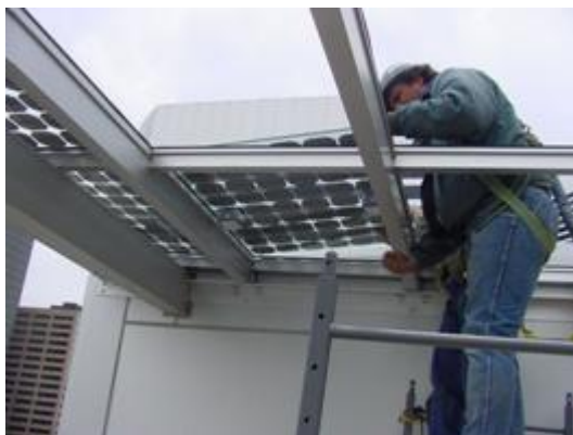
Εικ 3.11 Τοποθέτηση ενσωματωμένων Φ/Β
