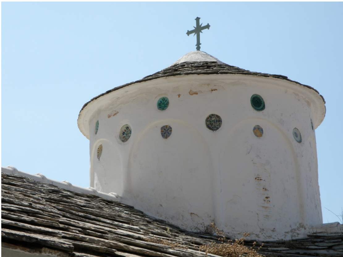
Εικόνα 31. Οι σχιστόλιθοι που έχουν χρησιμοποιηθεί για τη κατασκευή του τρούλου.
