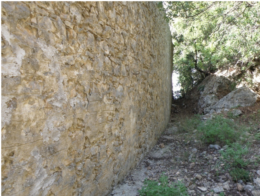
Εικόνα 11. Εξωτερικό τοίχος στην ανατολική πλευρά.
