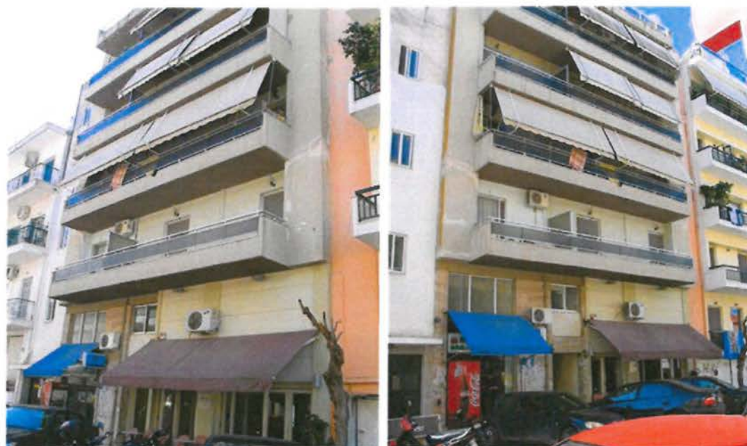
Εικόνα 9 Η πρόσοψη του κτιρίου μελέτης
