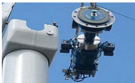
Σχήμα 10.2 Ανεμογεννήτρια (Συστατικά μιας ανεμογεννήτριας οριζόντιου άξονα (κιβώτιο ταχυτήτων, στροφείο άξονα και συναρμολόγηση φρένων) να ανυψωνεται σε θέση )
