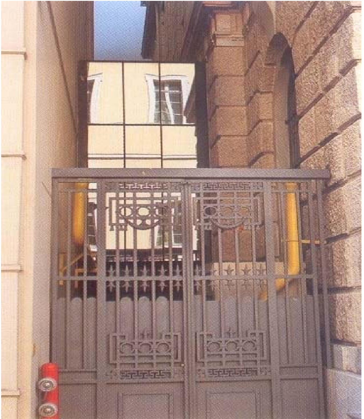
59. Άποψη του συνδετικού στοιχείου μεταξύ των 2 κτιρίων από την οδό Πεσμαζόγλου. [Πηγή: Φωτ/κό αρχείο Δ.Φιλιππίδης]
