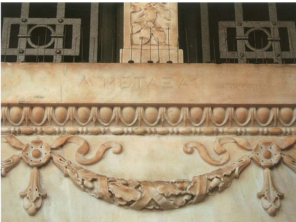
42. Μαρμάρινη «ροζέτα» κοσμεί το κάτω μέρος του παραθύρου του ισόγειου ορόφου της Ιονικής Τράπεζας. Διαδεδομένο είδος διακόσμησης την περίοδο του μεσοπολέμου.
