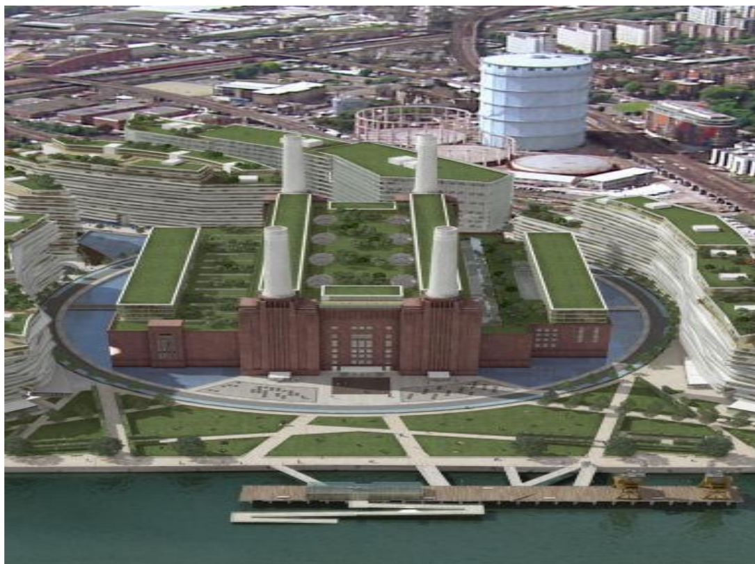
Εικόνα 21: Σταθμός παραγωγής ενέργειας στο Λονδίνο
