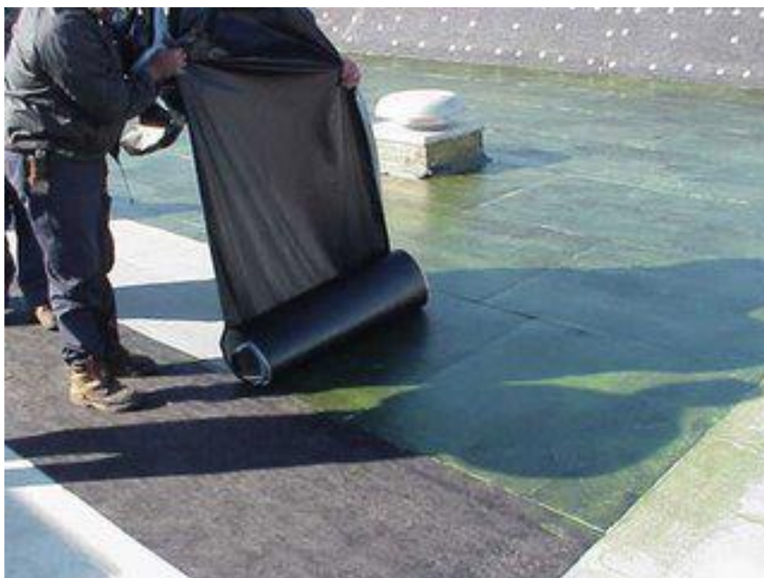
Εικόνα 10: Στεγάνωση Δώματος
