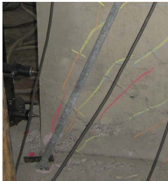
Σχήμα 6.16 Εξέλιξη της ρηγάτωσης κατά την επιβολή φορτίου ίσου με 100% της φέρουσας ικανότητας του δοκιμίου.
