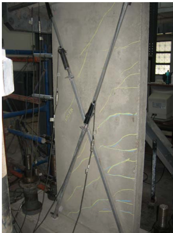
Σχήμα 6.13 Εξέλιξη της ρηγμάτωσης κατά την επιβολή φορτίου ίσου με 47% της φέρουσας ικανότητας (70kN, 9mm) του δοκιμίου.
