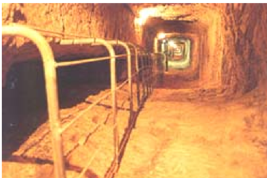
Εικ 25. Ευπαλίνειο Υδραγωγείο( http://ribfans.com )
