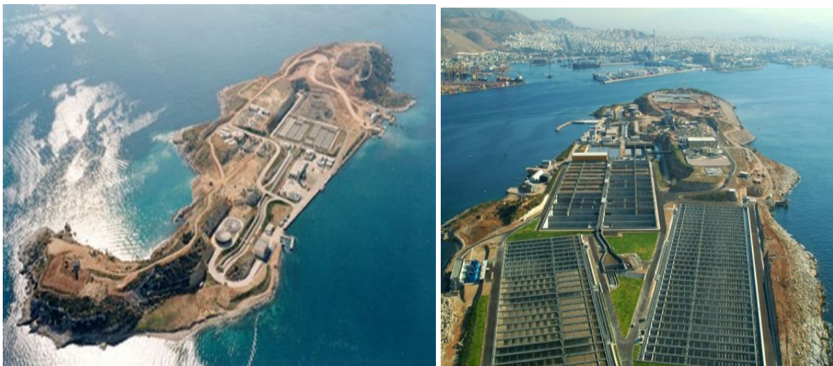
Εικόνα 4.15 Κέντρο Επεξεργασίας Λυμάτων Ψυτάλλειας
