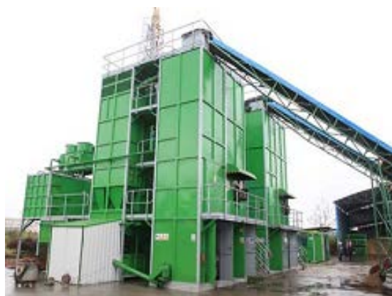
Εικόνα 4.3 Εγκαταστάσεις επεξεργασίας βιομάζας
