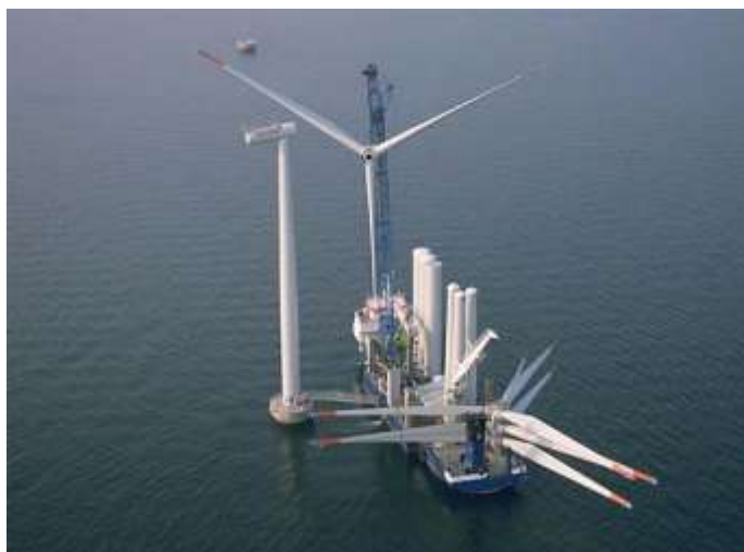
Εικόνα 5.1 Συναρμολόγηση ανεμογεννήτριας 5
