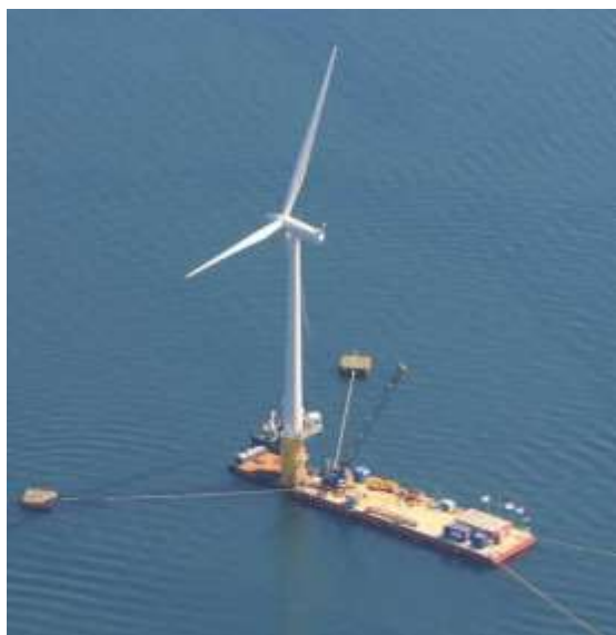
Εικόνα 4.11 Hywind (Spar buoy), η πρώτη παγκόσμια πολύ-μεγαβάτ πλωτή ανεμογεννήτρια 25 .
