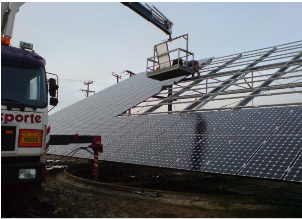
Εικόνα 4.1 Κατασκευή φωτοβολταϊκού πάρκου 100 kW p στο Κουλούριο Λάρισσας
