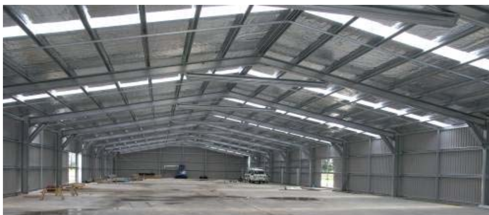
Εικ.32: Υπόδειγμα μεταλλικής στέγης
