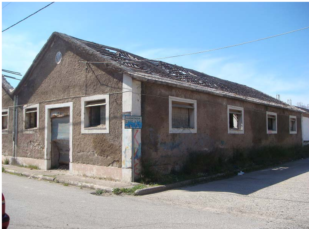
Εικ.4: Τμήμα του συγκροτήματος των αποθηκών
