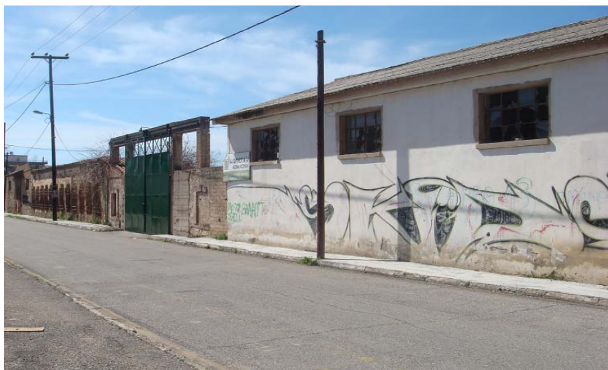
Εικ.30: Η νότια όψη των εξωτερικών αποθηκών
