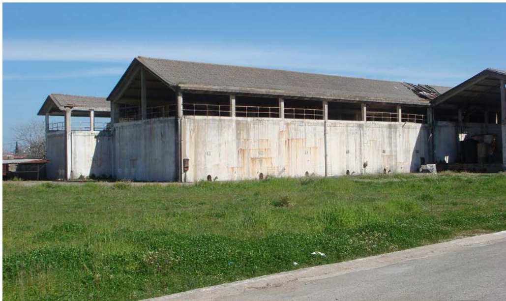
Εικ.20: Σημερινή άποψη της βόρειας πλευράς του παλιού οινοποιείου
