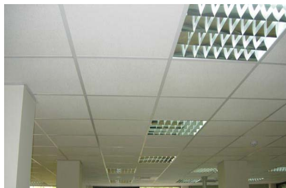
Εικ.16: Κατασκευή από ψευδοροφή
