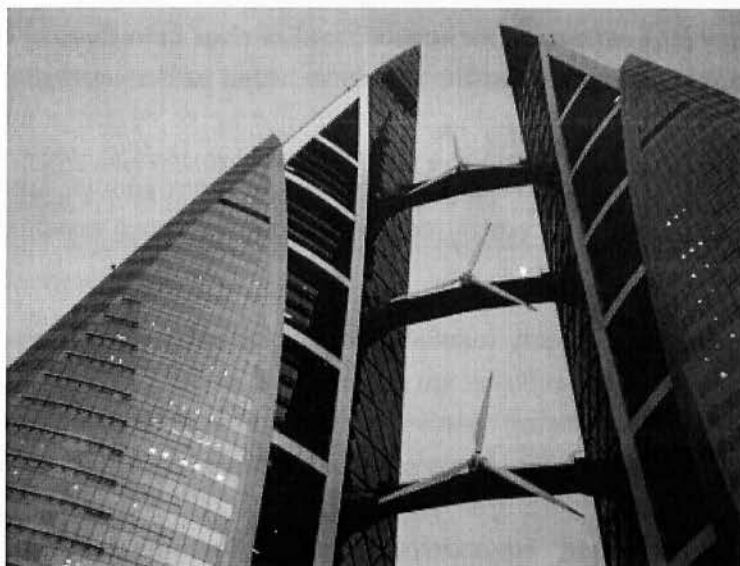
Εικόνα 1.3: Μικρές Α/Γ σε αρχιτεκτονική κτιρίου στο Bahrain.
