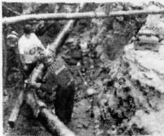
εικ. 2.19 Τοποθέτηση αγωγού - Θεσσαλονίκη
