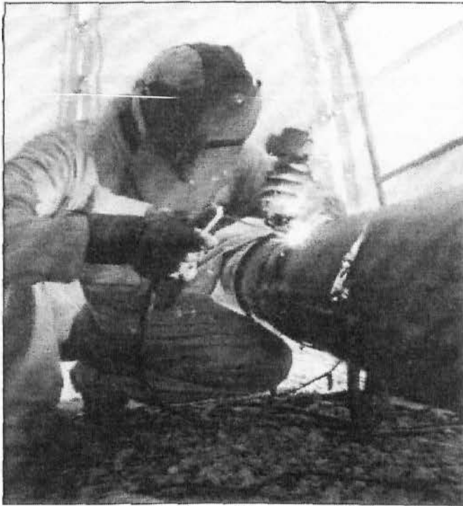
εικ.2.10 συγκόλληση αγωγού Φ.Α.
