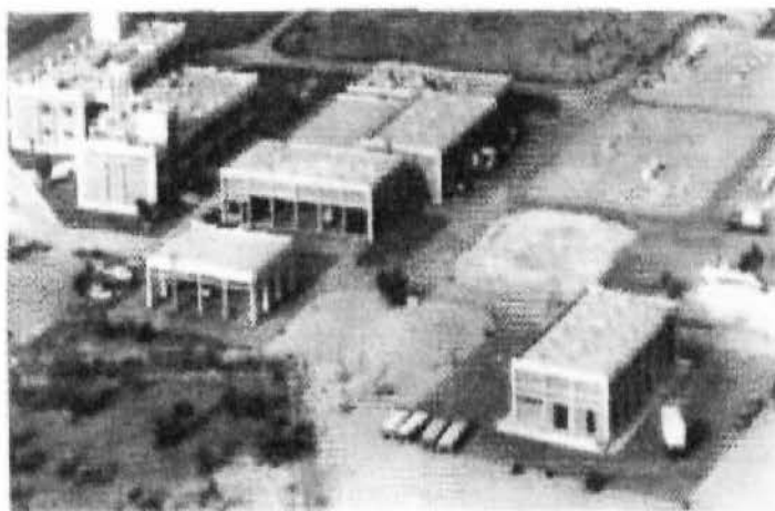
εικ.2.22 Κέντρο κατανομής και ελέγχου φορτίου Φ.Α. στο Πάτημα Ελευσίνιας
