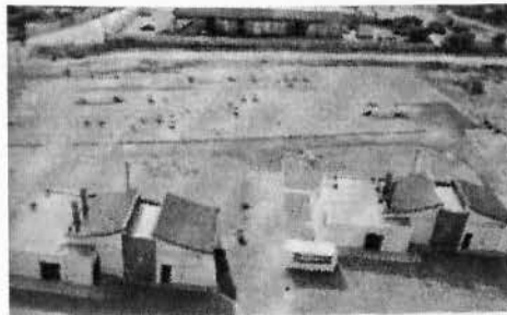
εικ. 2.16 Σταθμός μέτρησης και ρύθμισης Φ.Α
