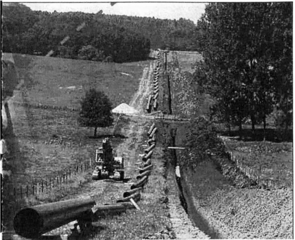
εικ.1.1 Φωτογραφία από την κατασκευή αγωγού του δικτύου Φ.Α.
