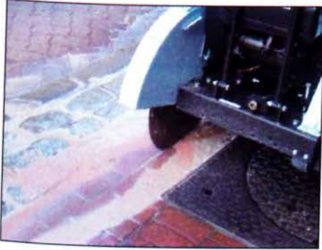
Σχήμα 29. Τυπικό μηχάνημα για τάφρο τύπου micro Trencher
