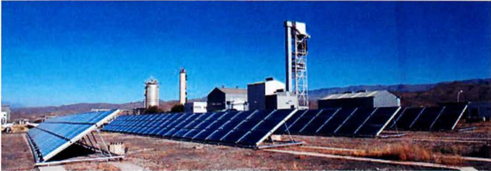
Σχήμα 3.1 Αφαλάτωση με πολυβάθμια εξάτμιση (MED) με συνδυασμό ηλιακών συλλέκτων στην ALEMRIA της Ισπανίας. Δυναμικότητα μονάδος 72 κβ/ημέρα. Πηγή : ProDes project
