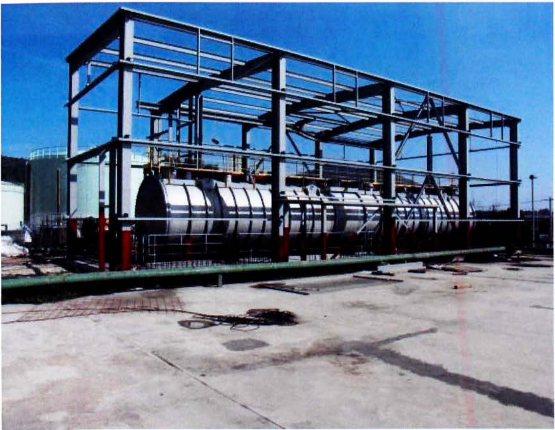
Σχήμα 2.8 Μονάδα αφαλάτωσης μηχανικής συμπίεσης ατμού (MVC) στην Alcudia της Ισπανίας με δυναμικότητα 1500 κβ/ημέρα. Πηγή : Φωτογραφικό αρχείο Entropie
