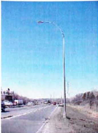
Σχήμα 3.6: Στόλος φωτισμού με καμπύλο βραχίονα
