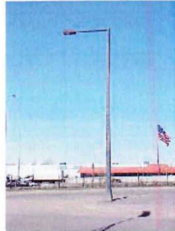
Σχήμα 3.7: Στόλος φωτισμού με ευθύγραμμο βραχίονα
