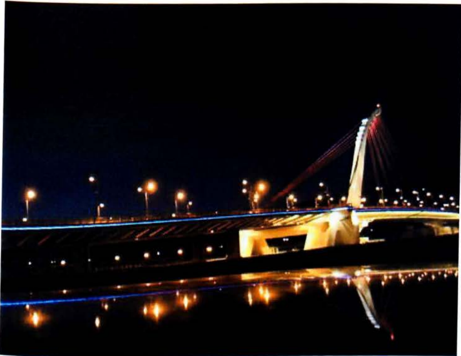
Σχήμα 4.3: Φωτισμός γέφυρας με φωτιστικά LED
