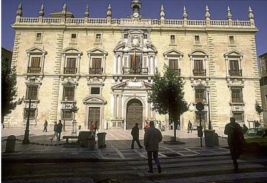
Εικόνα 34: Πρόσοψη του κτιρίου
