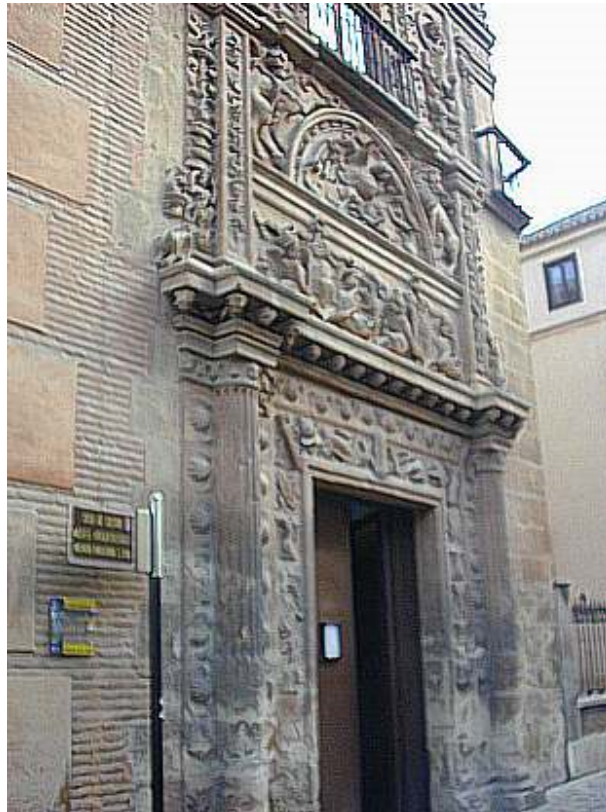
Εικόνα 48: Η πρόσοψη του κτιρίου
