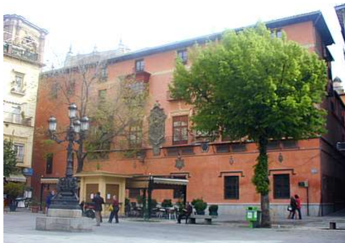
Εικόνα 24: Η πίσω όψη του κτιρίου
