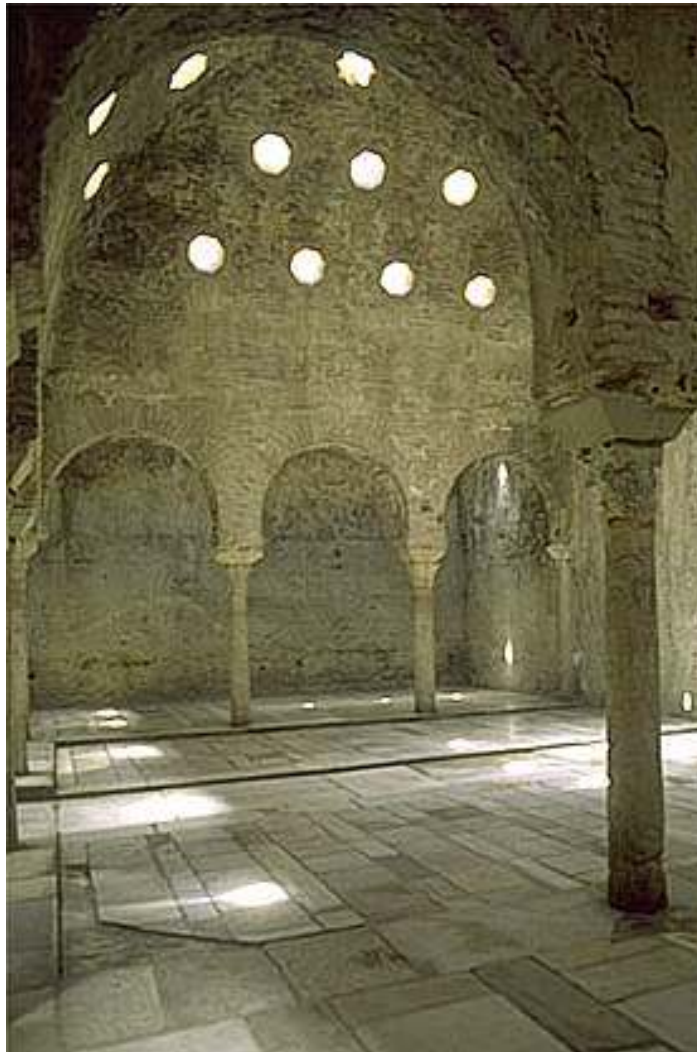
Εικόνα 41: Το εσωτερικό των λουτρών. Σε αυτήν την εικόνα φαίνονται και οι αραβικοί τρούλοι της κατασκευής
