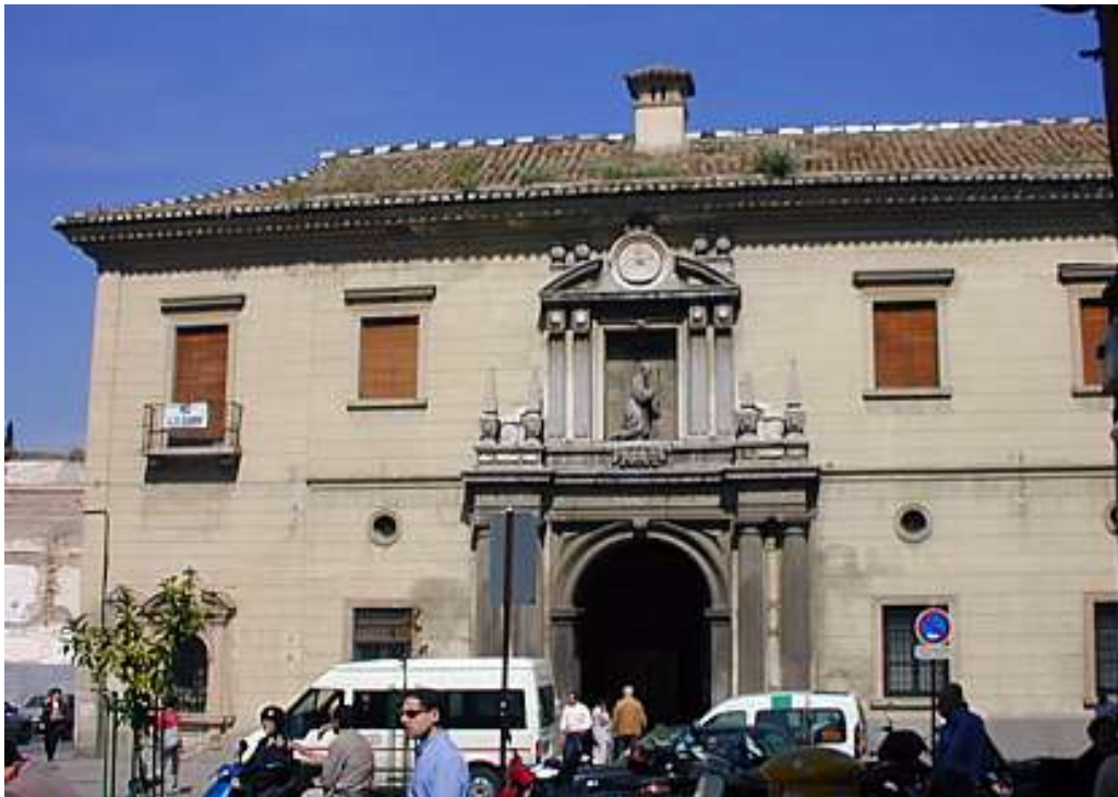
Εικόνα 7: Η εξωτερική όψη του νοσοκομείου
