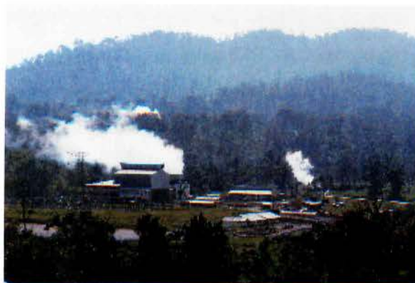
Σχήμα 3.63. Η εγκατάσταση ηλεκτροπαραγωγής του γεωθερμικού πεδίου Kamojang στην Ιάβα (Ινδονησία)
