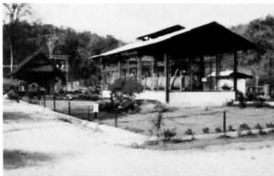
Σχήμα 3.62. Ο μικρός (300 kW) πολυσυναρτησιακός δυαδικός σταθμός ηλεκτροπαραγωγής στο Fang (Ταϊλάνδη)
