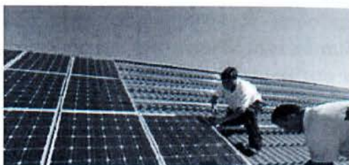
Σχήμα 1.6.1 Εγκατάσταση φωτοβολταϊκού πάνελ σε στέγη
